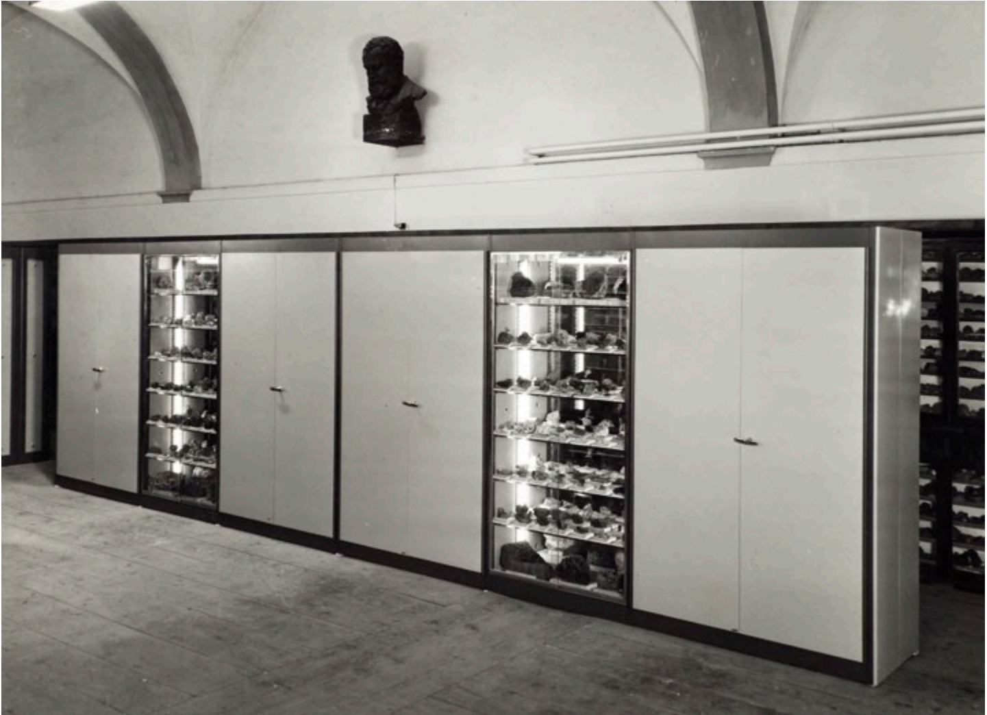
Fig. 13 Durante i lavori di sostituzione degli arredi in legno del salone, con quelli metallici (anni '60).
