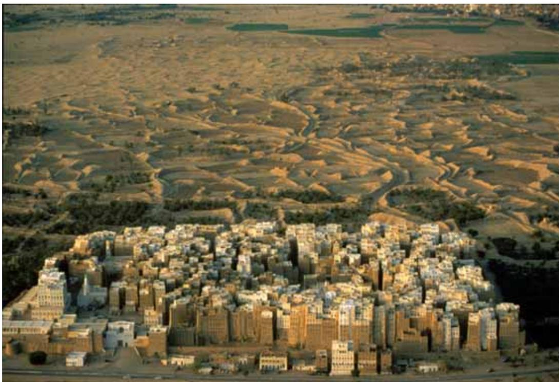
Figura 3. Shibam, nello Yemen, è interamente costruita con la terra cruda. È fatta di altissime torri di mattoni non cotti, ma solo lasciati seccare al sole.
