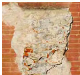
Distacco del velo di finitura. Detachment of the finishing layer.
