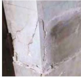
Distacchi e fessurazioni degli intonaci interni. Detachments and cracks in interior plasterwork.
