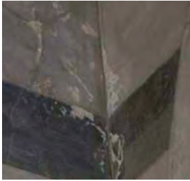
Distacchi e fessurazioni degli intonaci interni. Detachments and cracks in interior plasterwork.
