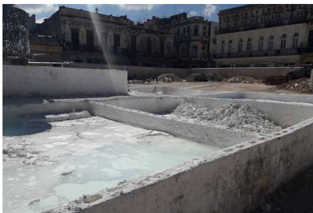
Fig. 9 - Vasche di stagionatura della calce. L'idratazione della calce produce idrossido di calce in forma di portlandite, questo composto viene fatto maturare in apposite vasche per acquisire notevoli proprietà plastiche.
