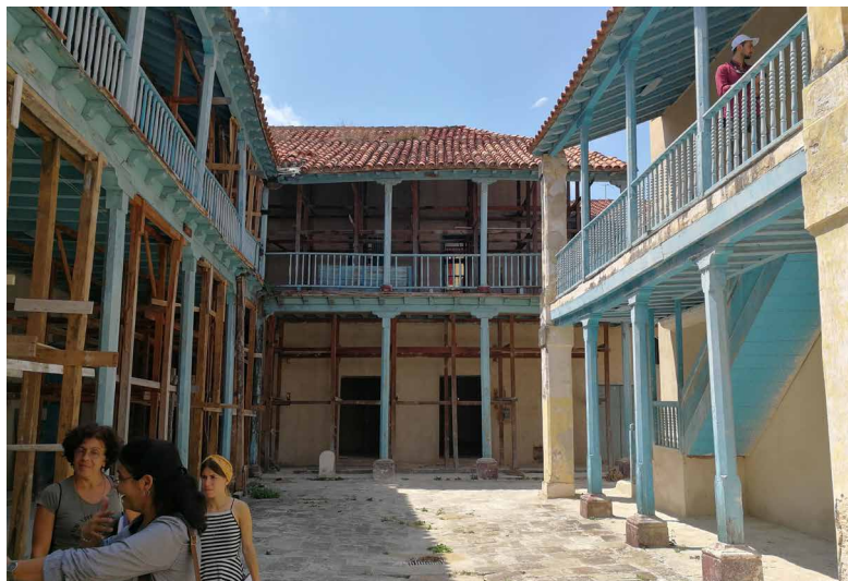
Interno del secondo Chiostro. Interior del segundo Claustro.
