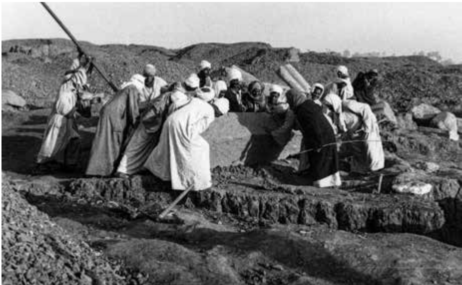
Fig. 6. Operai intenti a spostare i frammenti delle colonne di granito nel settore centrale dello scavo; fotografia di Claudio Barocas.
