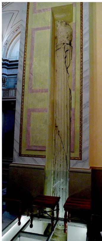
Figura 2 – Resti di una delle colonne inserite nei pilastri della chiesa di S. Pancrazio.
