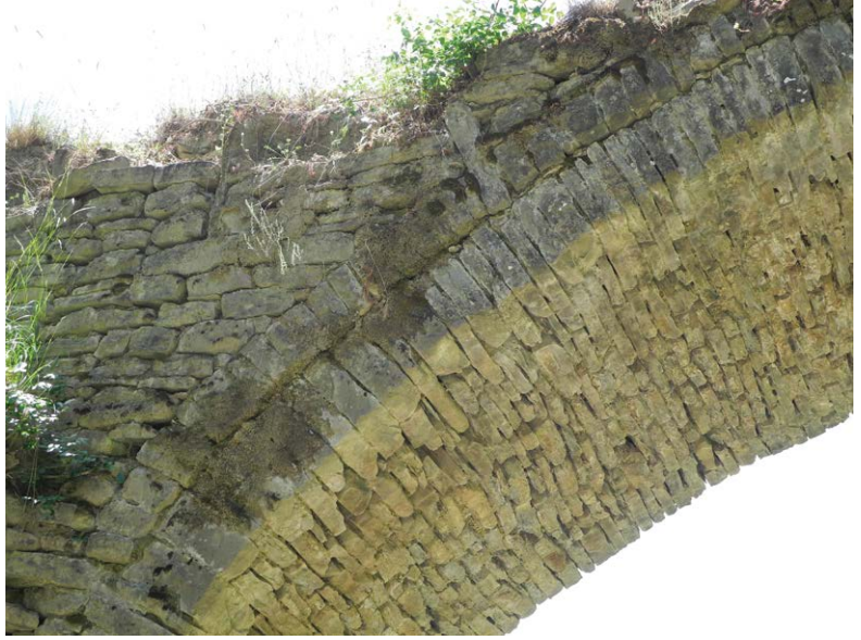
Figure 3.40 – Bënjë Bridge, the stone archivolts and the intrados.
