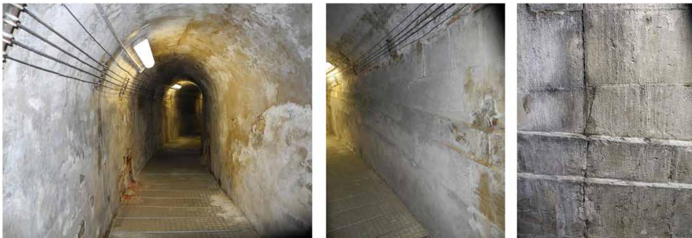
Fig. 39 - Palazzo Pitti, seminterrato del rondò delle Carrozze; (sinistra e sotto) corridoio tra il margine semicircolare della terrazza riconducibile all'attività di Giuseppe Ruggieri e il lato interno della parete a grandi conci opera di Pasquale Poccianti; (centro e destra) dettagli del paramento murario opera di Ruggieri che delimitava il terrapieno semicircolare della terrazza originaria.
