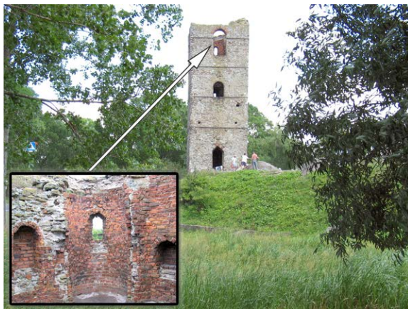
Figura 2 – Torre di Stołpie con una cappella ottagonale all'ultimo piano (secondo A. Buko).
