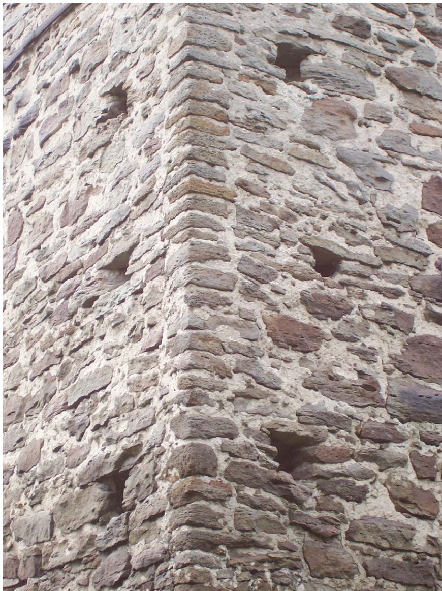
Figura 3 – La parte esterna del muro della torre (foto A. Buko).
