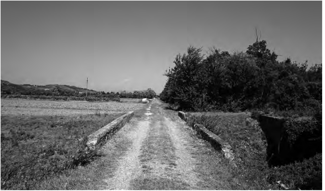
fig.3 Ponte sopra Fossa Nuova su strada campestre (parallela a sedime ferroviario, a destra, invaso dalla vegetazione).
