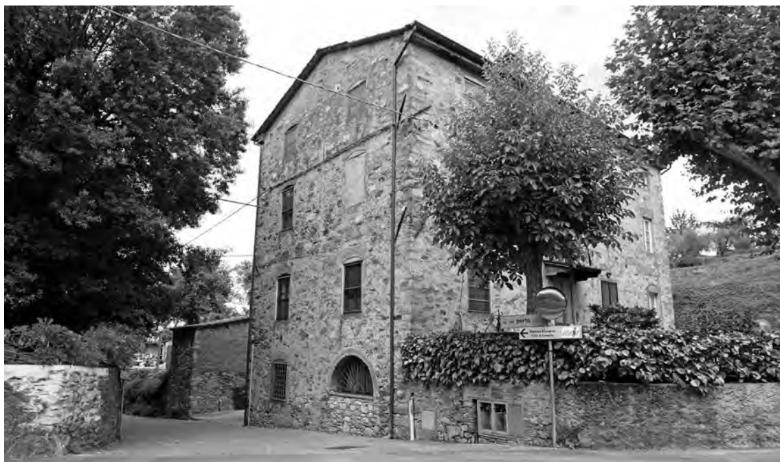
fig.20 Casa all'intersezione tra via di Tiglio e via del Porto.
