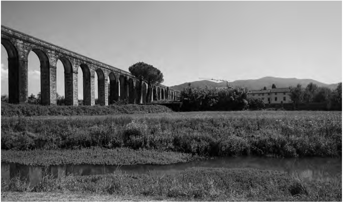
fig.31 Intersezione tra l'Acquedotto del Nottolini ed il Canale Ozzeri.
