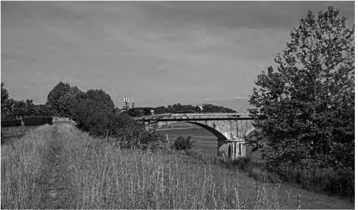
fig.7 Campanile della chiesa di Calcinaia e Villa Lawley intraviste dall'argine dell'Arno nei pressi del ponte ferroviario.
