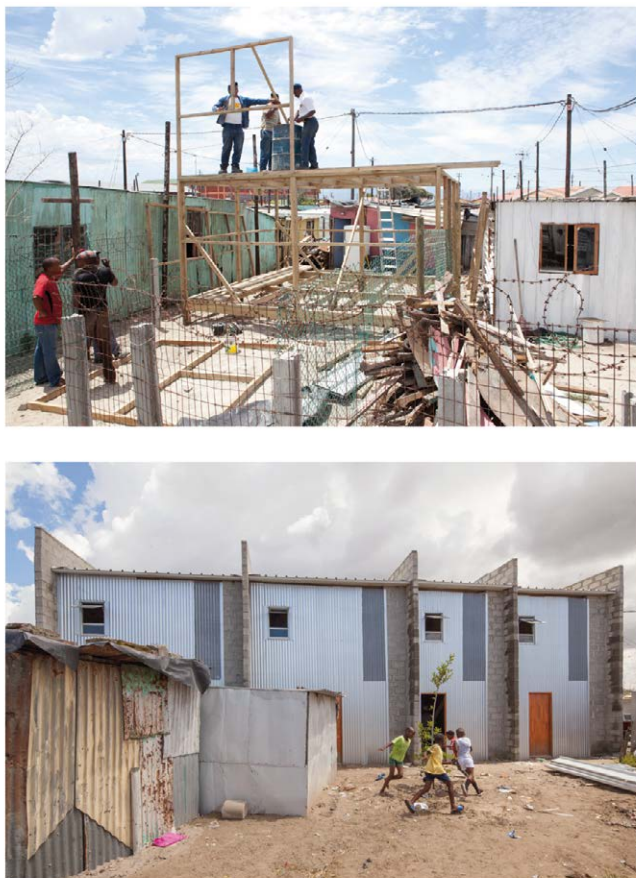
Figura 6.8 – La costruzione di alloggi promossa dal progetto EmpowerShacks. Didascalia: costruzione di alloggi nella BT-section di Khayditsha, Città del Capo. Fonte: NSL 2015.
