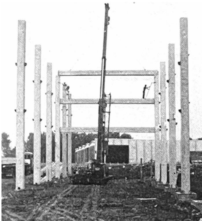
Figura 2.16 – Sistema Borini 2: pilastri multipiano prefabbricati adottati per il centro di formazione professionale a Biella (1983 ca.). ASTO-Borini, 1764/7.
