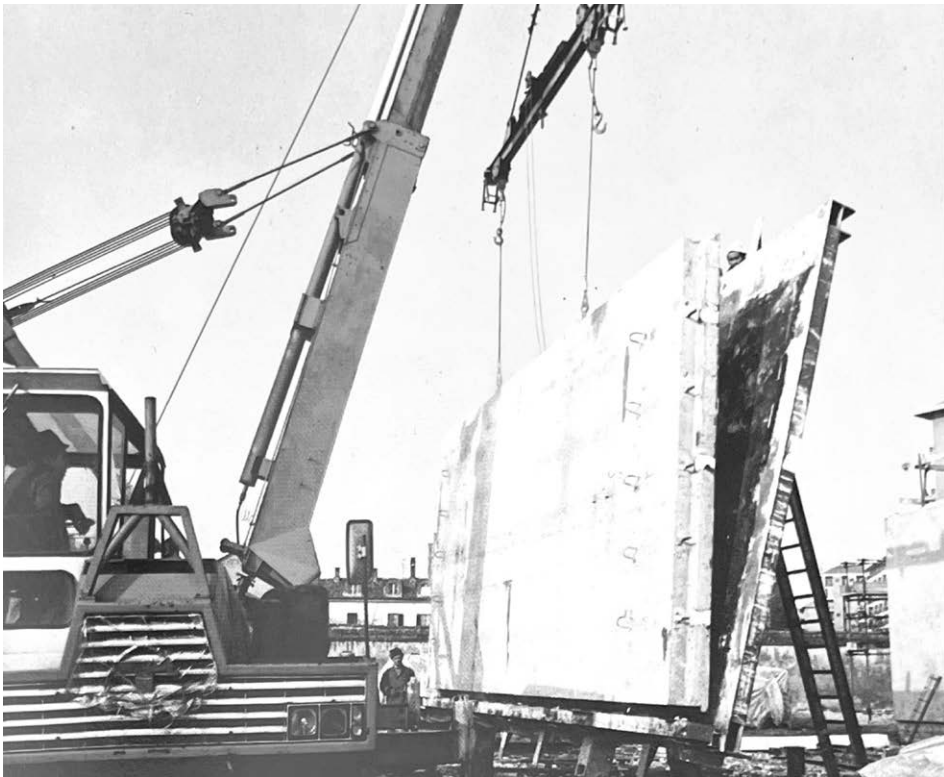
Figura 2.6 – Sistema Borini 1: movimentazione di un pannello agevolato dalla cassaforma basculante. ASTO-Borini, 1764/7.
