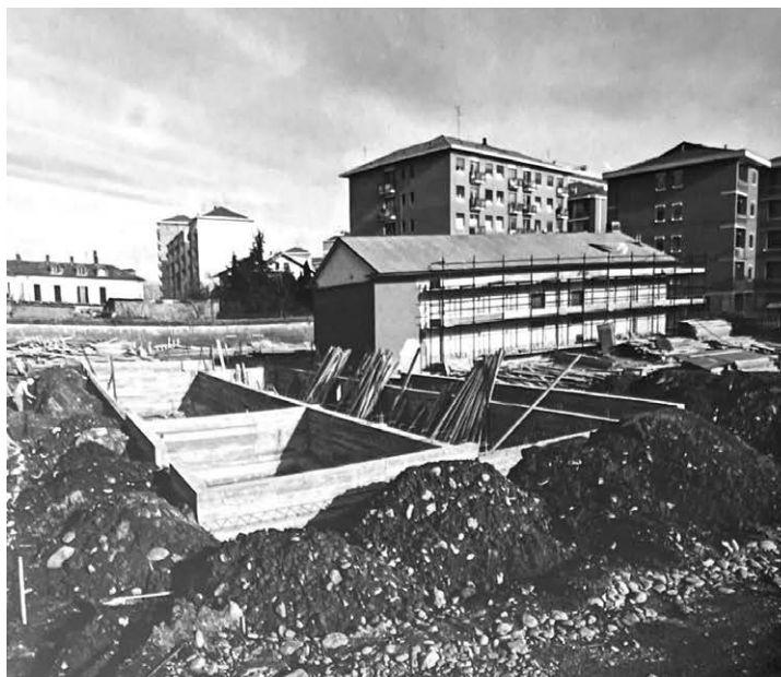
Opere di fondazione del nuovo ampliamento con veduta dell'edificio centrale esistente.
