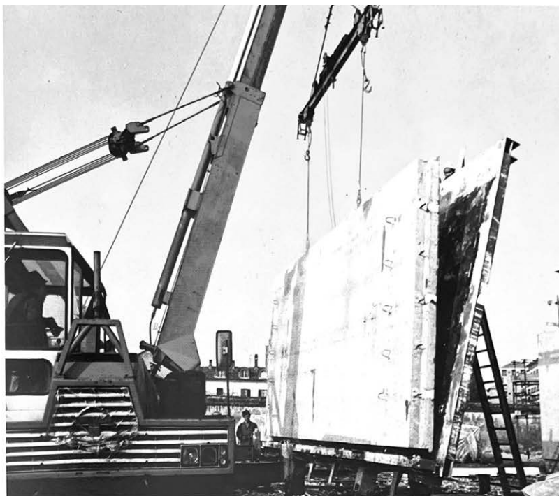
Disarmo di una lastra di solaio.
