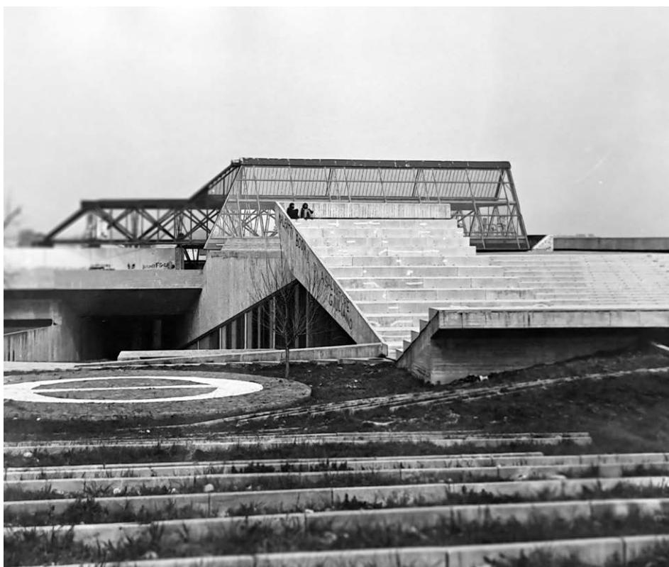
Figura 4.11 – Le gradonate, composte di elementi prefabbricati, integrate nella copertura dell'unità polifunzionale. APCA.
