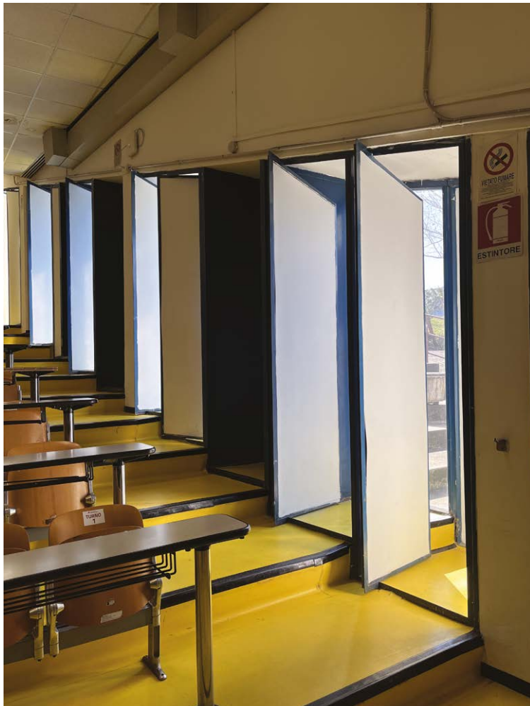
Figure 4.34 – 4.36 – Dettagli dei pannelli rotanti e delle vetrate dell’aula. Foto degli autori, 2025.
