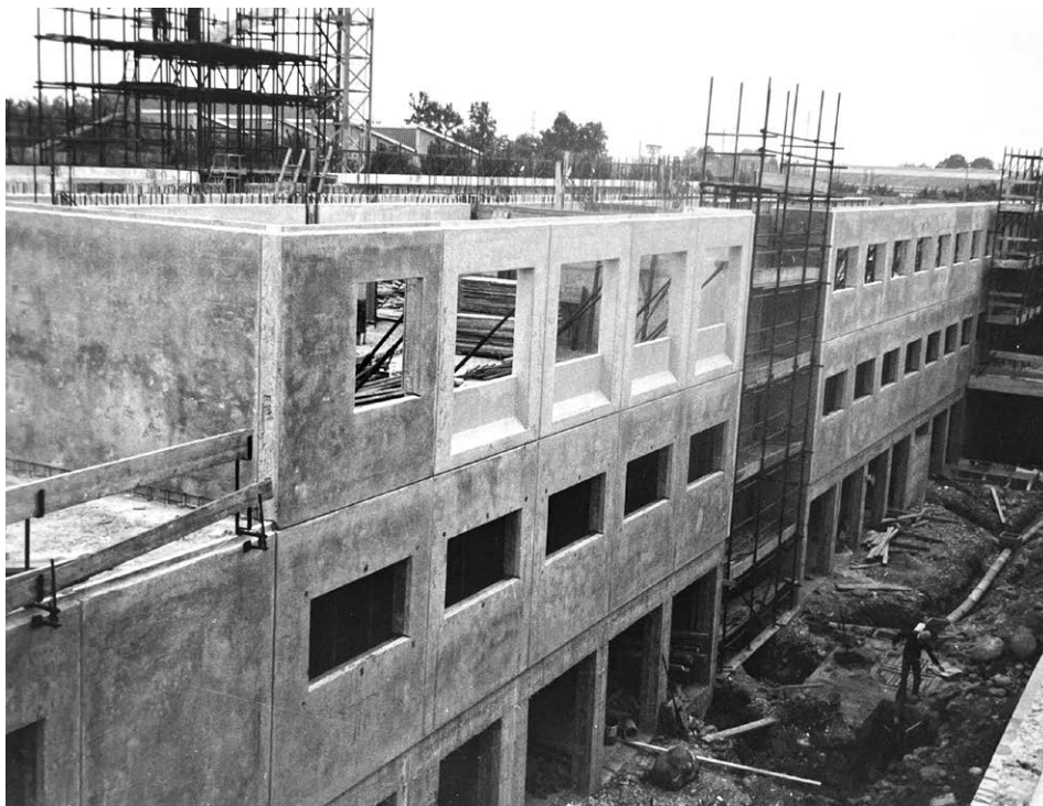
Figura 2.9 – Sistema Borini 1: montaggio dei pannelli di facciata. ASTO-Borini, 1764/7.
