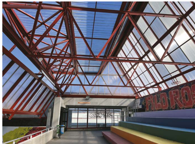
Figura 4.19 – La piazza coperta oggi. In primo piano la struttura del grande lucernario. Foto degli autori, 2025.
