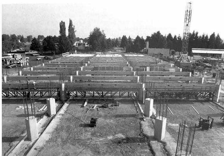
Figura 1.12 – Parcheggio dell'aeroporto di Torino-Caselle (1989-90): getto delle travi mediante attrezzatura mobile metallica idraulica, scorrevole su rotaia. ASTO-Borini, 1764/7.
