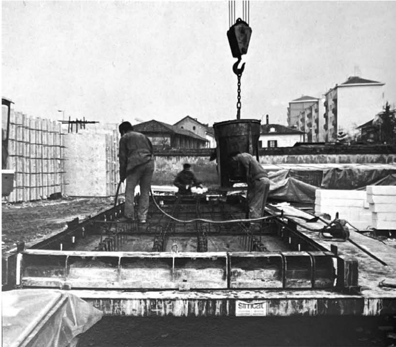
Getto del primo strato di calcestruzzo di una lastra di solaio.
