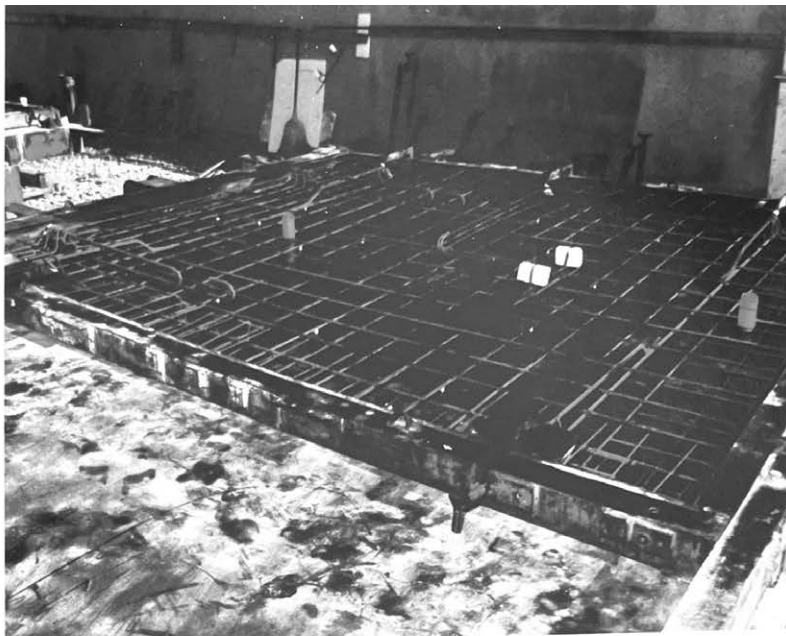
Stampo di solaio con l'inserimento delle cassette in plastica per punti luce.
