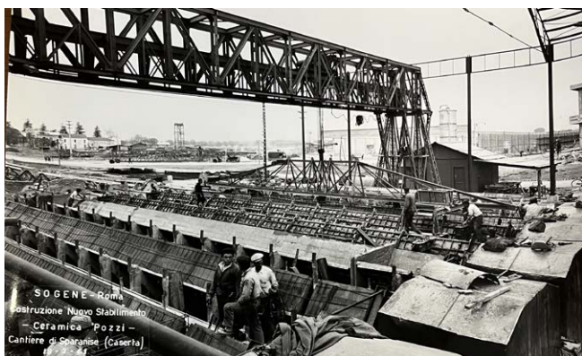
Figura 3.2 – Il cantiere di prefabbricazione allestito nell'area del complesso Pozzi. ACS-Sogene, f. 4091, b. 72.
