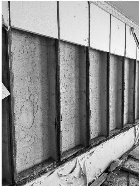
Figure 3.13-3.14 – Scuola elementare Tajani a Cutro. Vista della struttura al piano primo e dettaglio della faccia interna dei pannelli di calcestruzzo vibrato. Foto degli autori, 2025.
