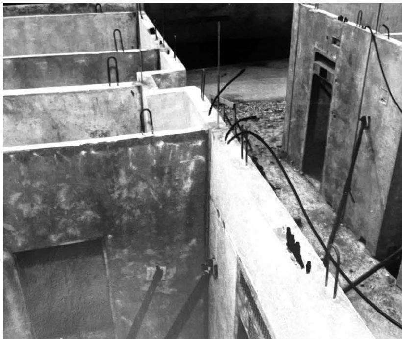
Particolari fuori uscita delle tubazioni dell'impianto elettrico incorporate.
