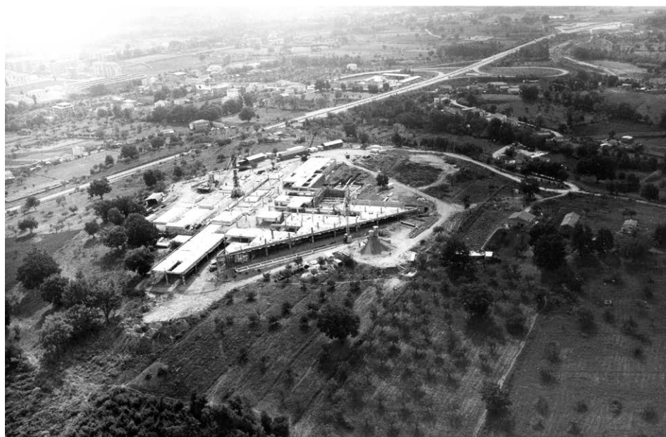
Figure 4.24 – 4.25 – Il cantiere dell'unità e l'area di prefabbricazione allestita da Borini. APCA.
