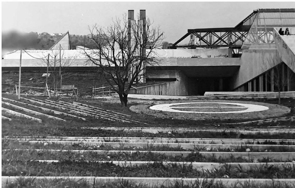
Figura 4.10 – Gli spazi verdi e attrezzati dell'Unità polifunzionale. Sullo sfondo la copertura di acciaio e vetro del lucernario a sei falde. APCA.
