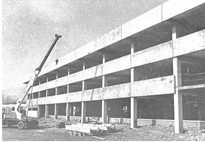
Figura 2.19 – Sistema Borini 2: assemblaggio dei pannelli di facciata del centro di formazione professionale a Biella (1983 ca.). ASTO-Borini, 1764/7.
