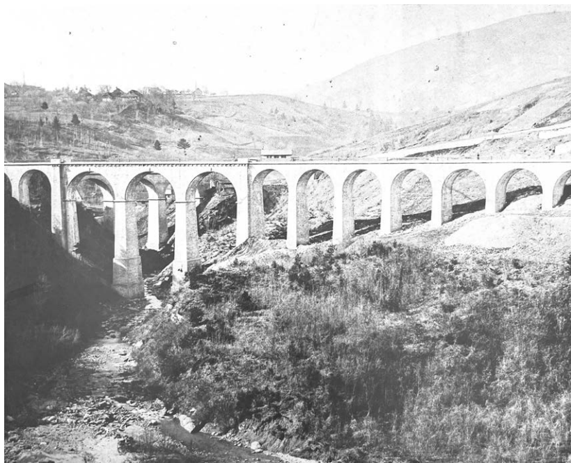
Figura 1.2 – Viadotto del Vaison (1871-74). ASTO-Borini, 1764/3.
