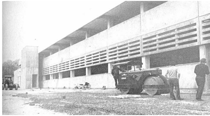
Figura 2.20 – Sistema Borini 2: assemblaggio dei pannelli di facciata del centro di formazione professionale a Biella (1983 ca.). ASTO-Borini, 1764/7.
