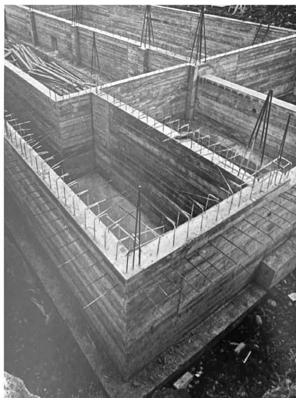
Particolare dei muri di fondazione in calcestruzzo armato gettato in opera.
