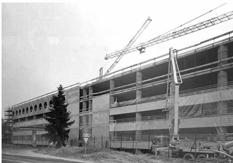
Figura 1.13 – Parcheggio dell'aeroporto di Torino- Caselle (1989- 90): montaggio dei pannelli prefabbricati di facciata. ASTO- Borini, 1764/7.
