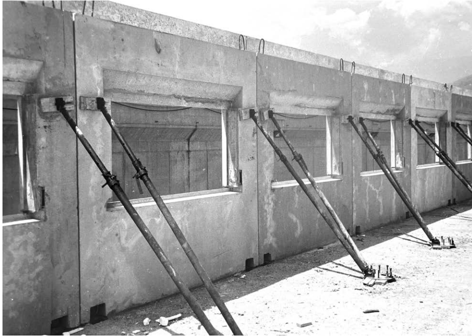
Figura 2.8 – Sistema Borini 1: montaggio dei pannelli mediante puntelli regolabili a cannocchiale ancorati sul solaio. ASTO-Borini, 1764/7.
