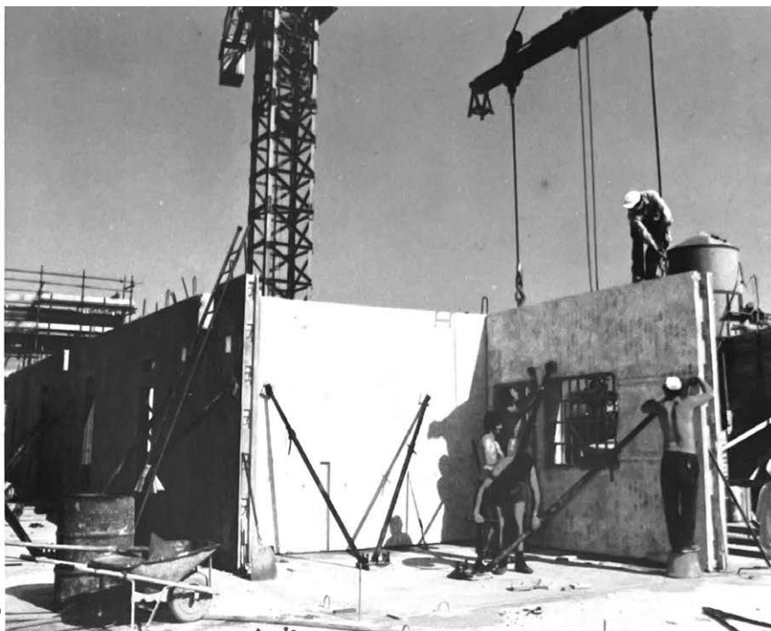
Posizionamento di un elemento di facciata
