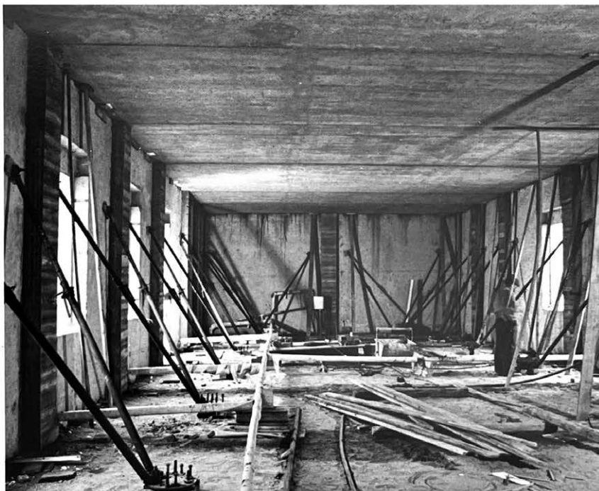
Vista interna del sopralzo dell'edificio esistente a montaggio ultimato.
