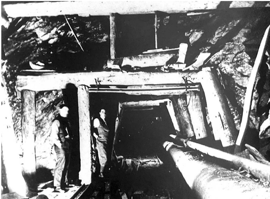
Figura 1.5 – Lavori di scavo della grande galleria dell'Appennino sulla direttissima Firenze-Bologna (1928). ASTO-Borini, 1764/3.
