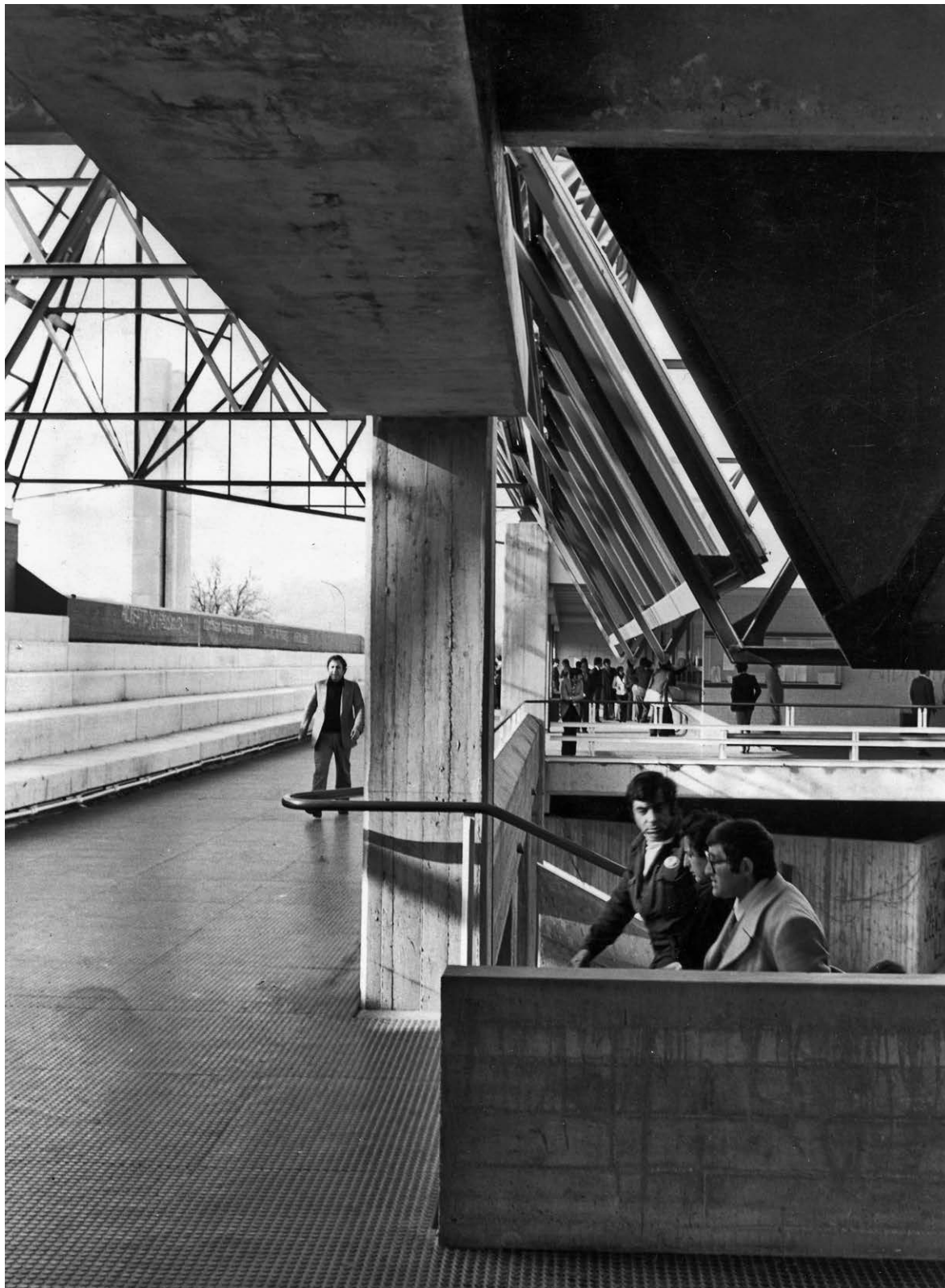
Figura 4.14 – Vista dei percorsi interni, che attraversano il complesso dalle quote più basse fino alla piazza e al teatro all'aperto. APCA.
