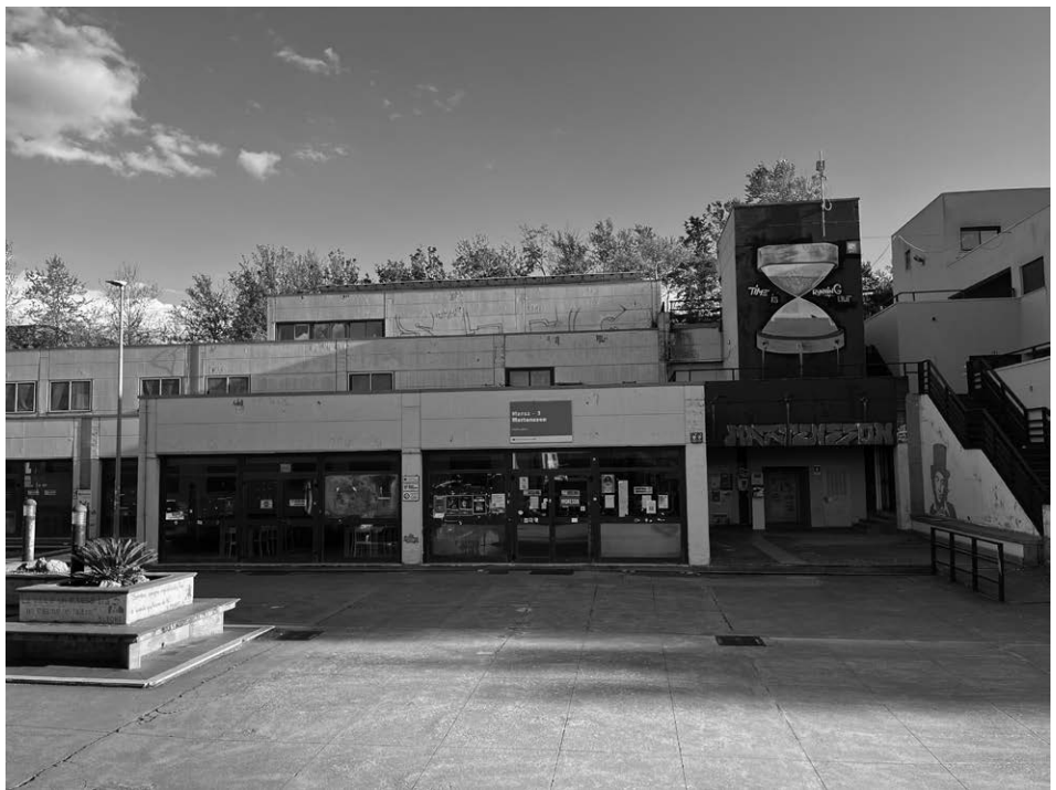
Figure 3.18-3.19 – Le residenze per studenti Martensson nel campus dell'Università della Calabria, realizzate, su progetto del gruppo Martensson-Tarp- Jansen. Foto degli autori, 2025.
