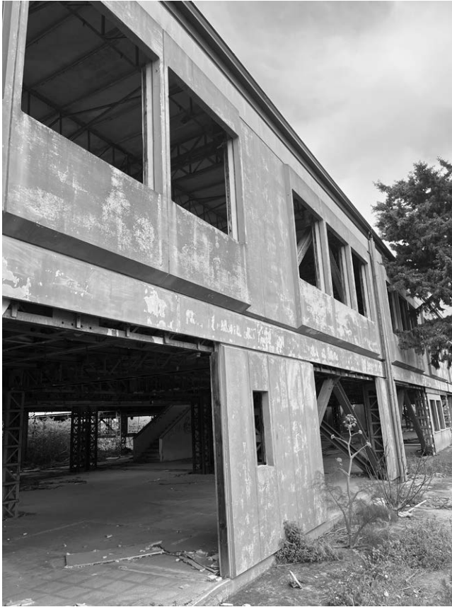
Figura 3.12 – Scuola elementare Tajani a Cutro. L'edificio è oggi in attesa di una rifunzionalizzazione. Foto degli autori, 2025
