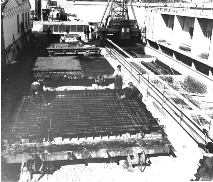
Veduta degli stampi di facciata e dei muri portanti con impianto di betonaggio sullo sfondo.
