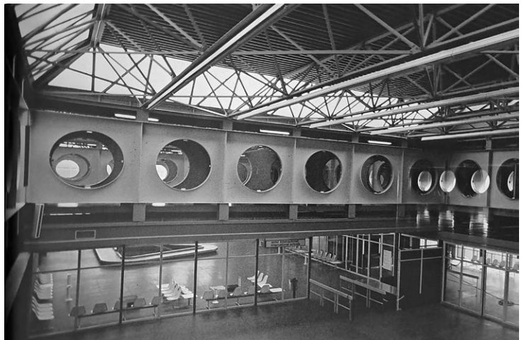
Figura 3.11 – Vista interna della sala passeggeri. ACS-Gatti De Sanctis, b. 100.
