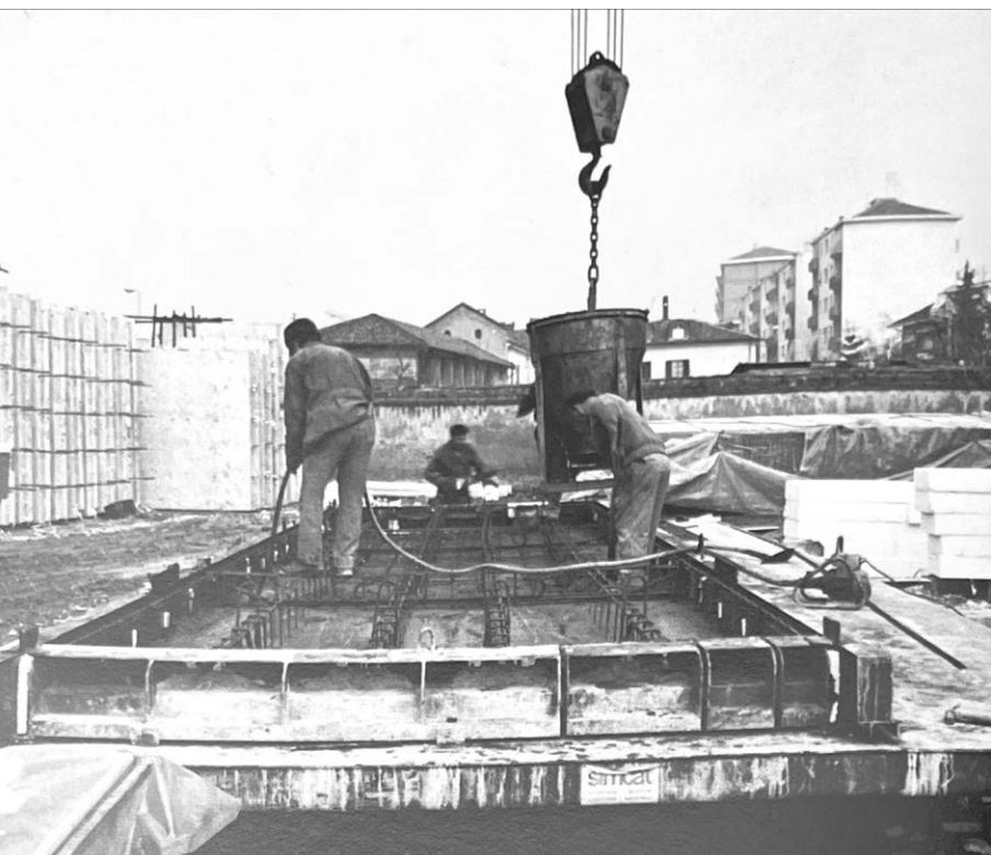
Figura 2.3 – Sistema Borini 1: cassaforma per il getto dei pannelli. ASTO-Borini, 1764/7.
