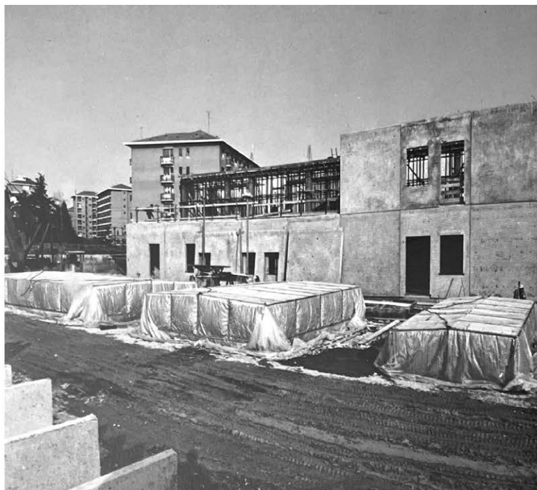
Vista del cantiere di prefabbricazione con i pannelli in fase di maturazione a vapore.
