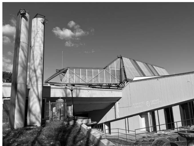
Figure 3.15 – 3.17 – L'unità polifunzionale dell'Università della Calabria. La copertura leggera di acciaio e vetro è inserita nell'insieme del complesso, realizzato con una struttura di calcestruzzo armato, largamente prefabbricata. Foto degli autori, 2025.
