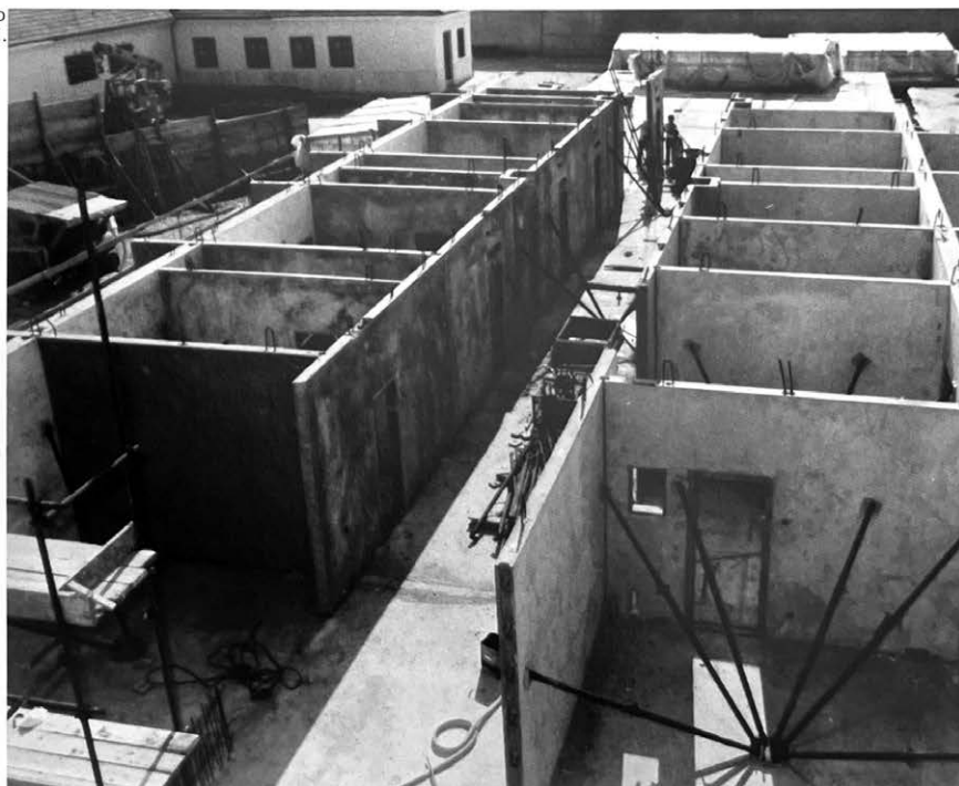
Veduta di un piano montato con i controventi provvisori.
