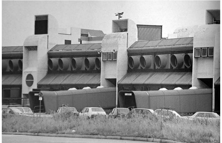
Figura 3.10 – Terminal passeggeri dell'aeroporto di Sant'Eufemia-Lamezia Terme, realizzato da De Lieto Costruzioni generali. In evidenza i pannelli di vetroresina del fronte principale. ACS-Gatti De Sanctis, b. 100.
