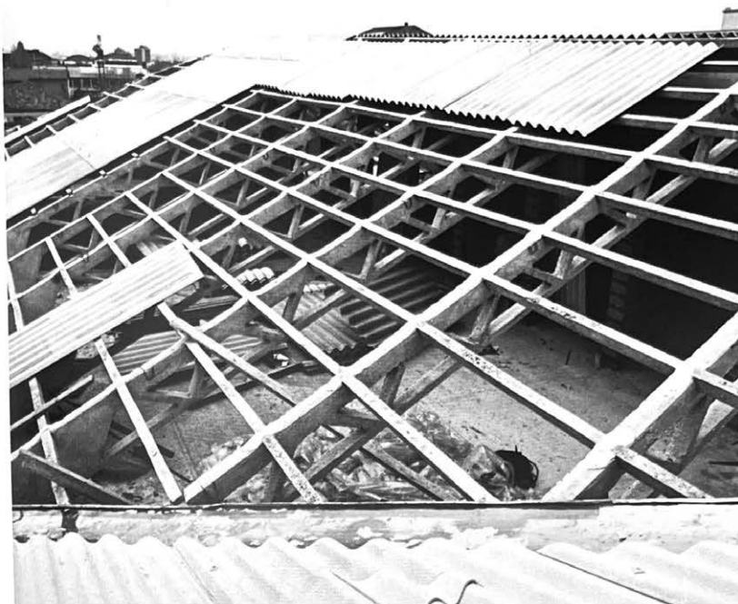
Particolare della struttura di copertura in C.A. prefabbricata.
