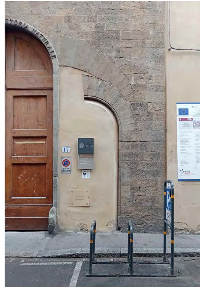
Fig. 6 - Palazzo Bini Torrigiani, fronte principale, resti del portale
