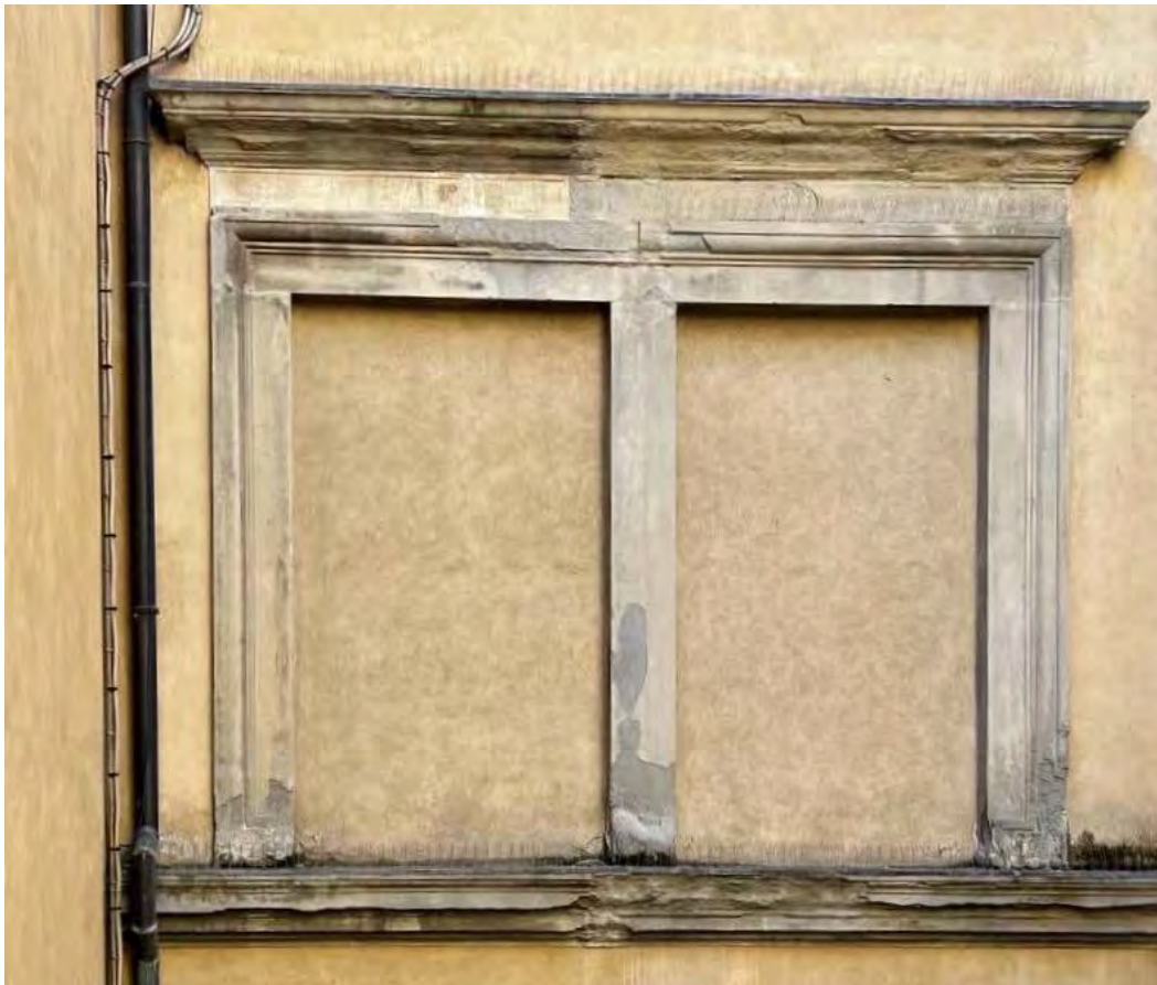
Fig. 20 - Finestra tamponata del piano nobile
