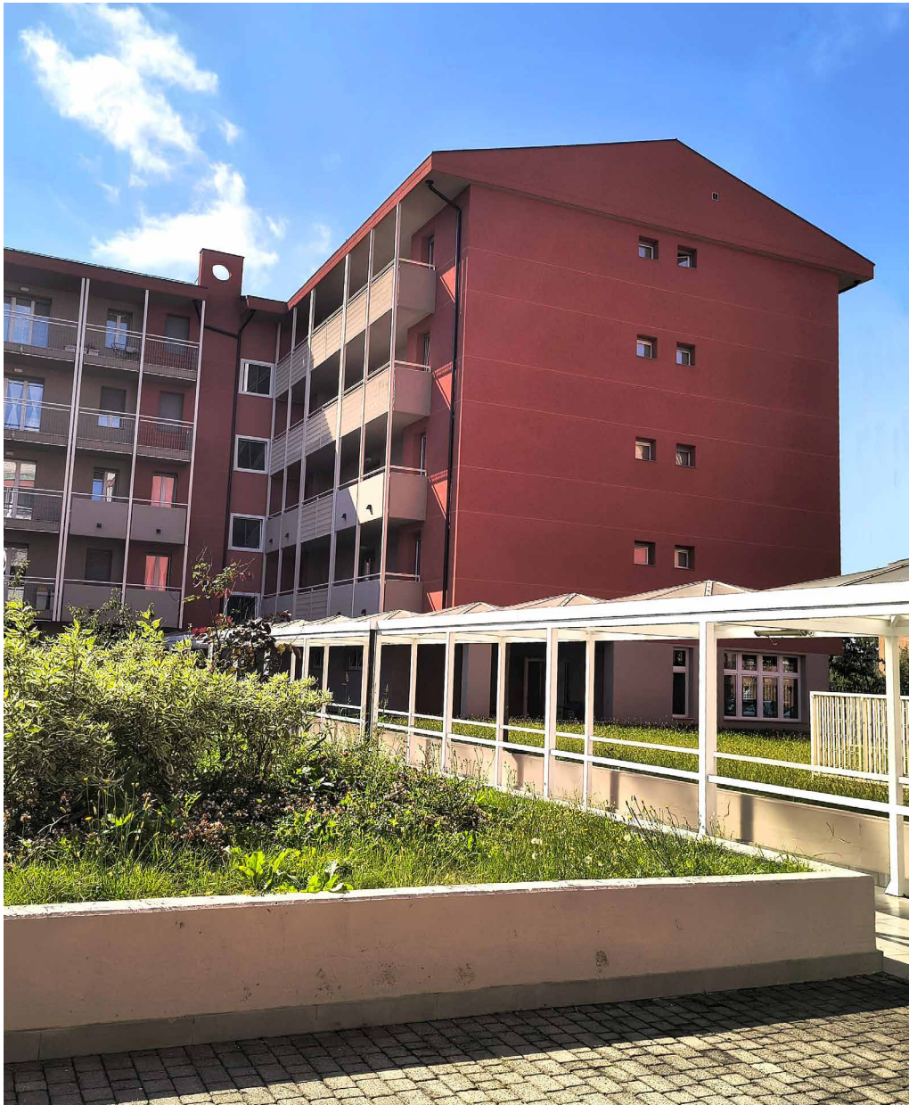
Fig. 51 L'affaccio interno di uno dei due fabbricati e la passerella di collegamento.
