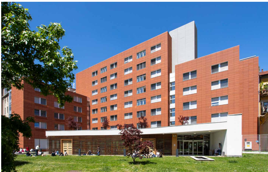
Fig. 95 Vista interna della residenza. In basso il piccolo volume in legno che ospita la libreria.
