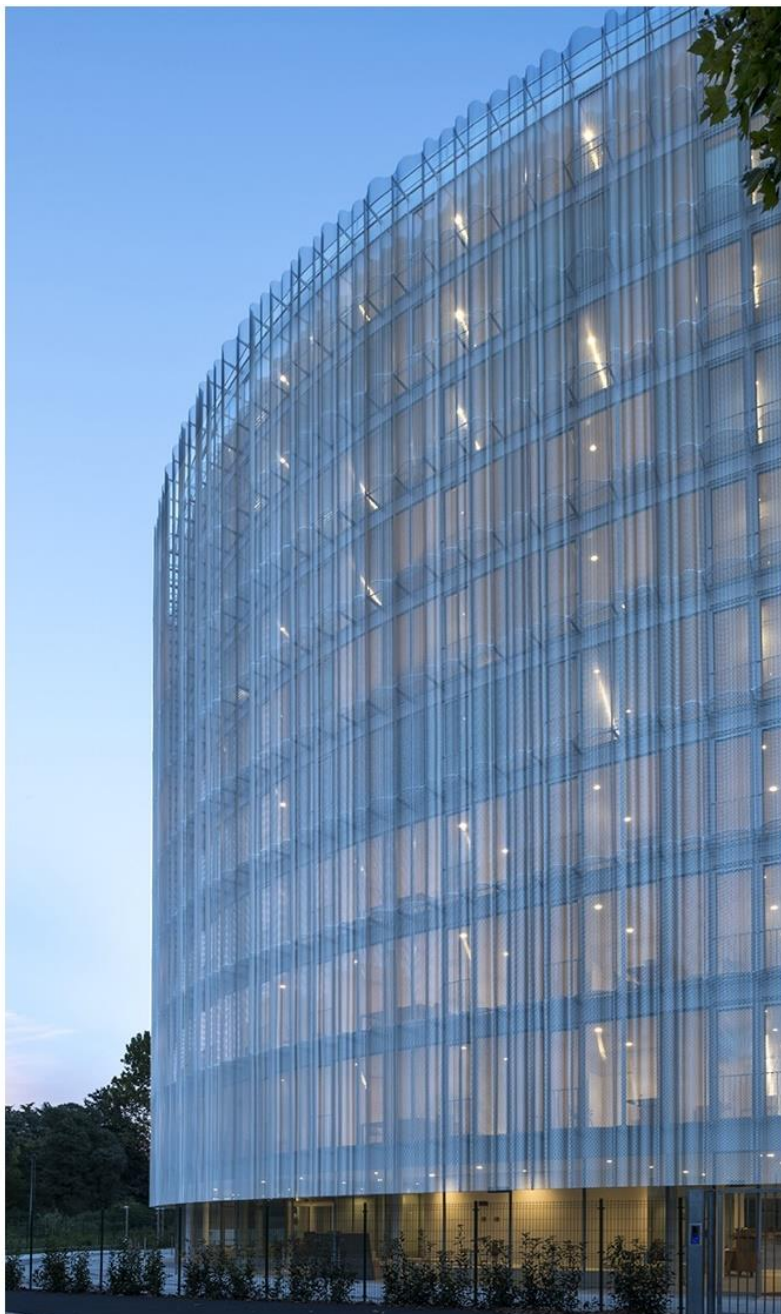
Fig. 115 L'involucro in rete metallica ondulata semitrasparente.
