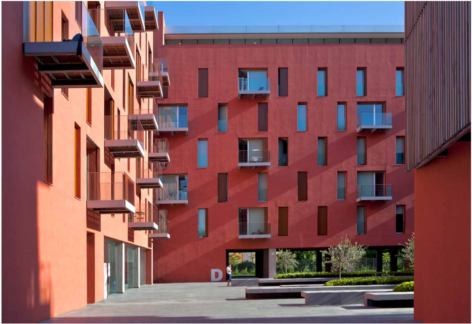
Fig. 70 La continuità tra spazi interni ed esterni.
