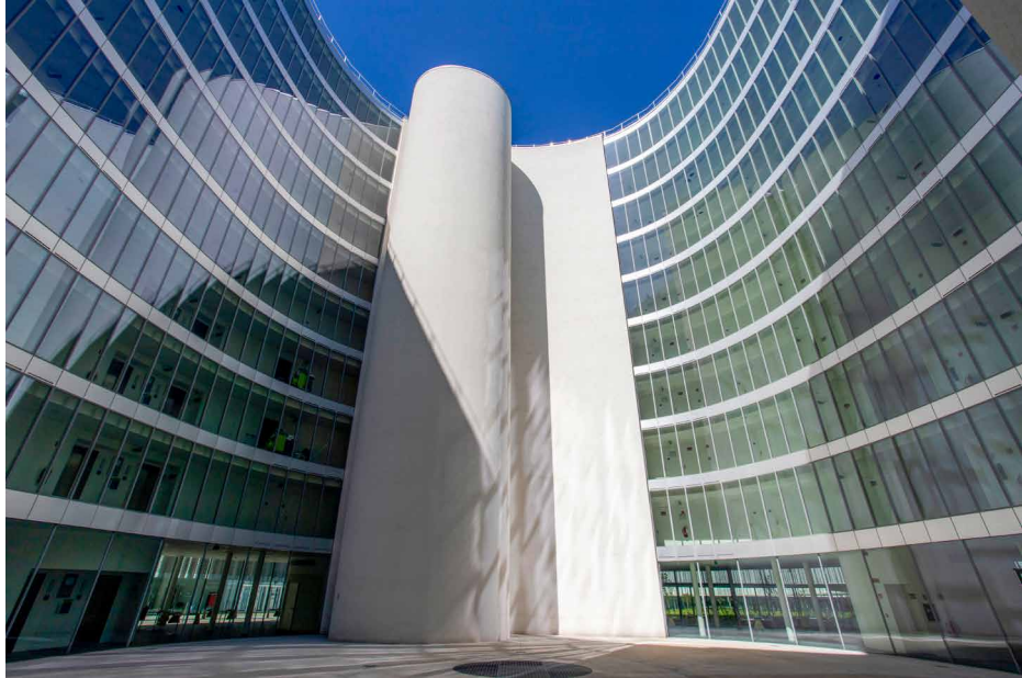
Fig. 113 - Uno dei collegamenti verticali che disegnano la corte.
