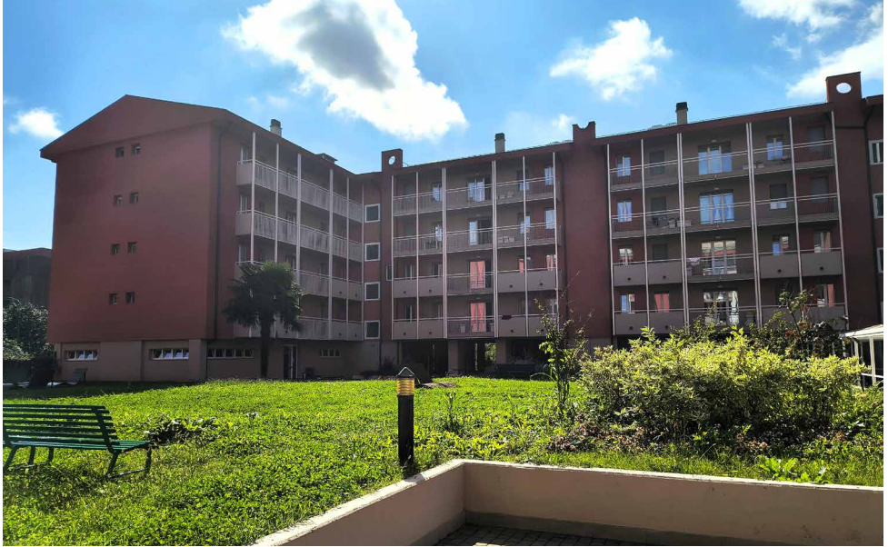
Fig. 58 - I balconi delle camere che si affacciano sulla corte interna.
