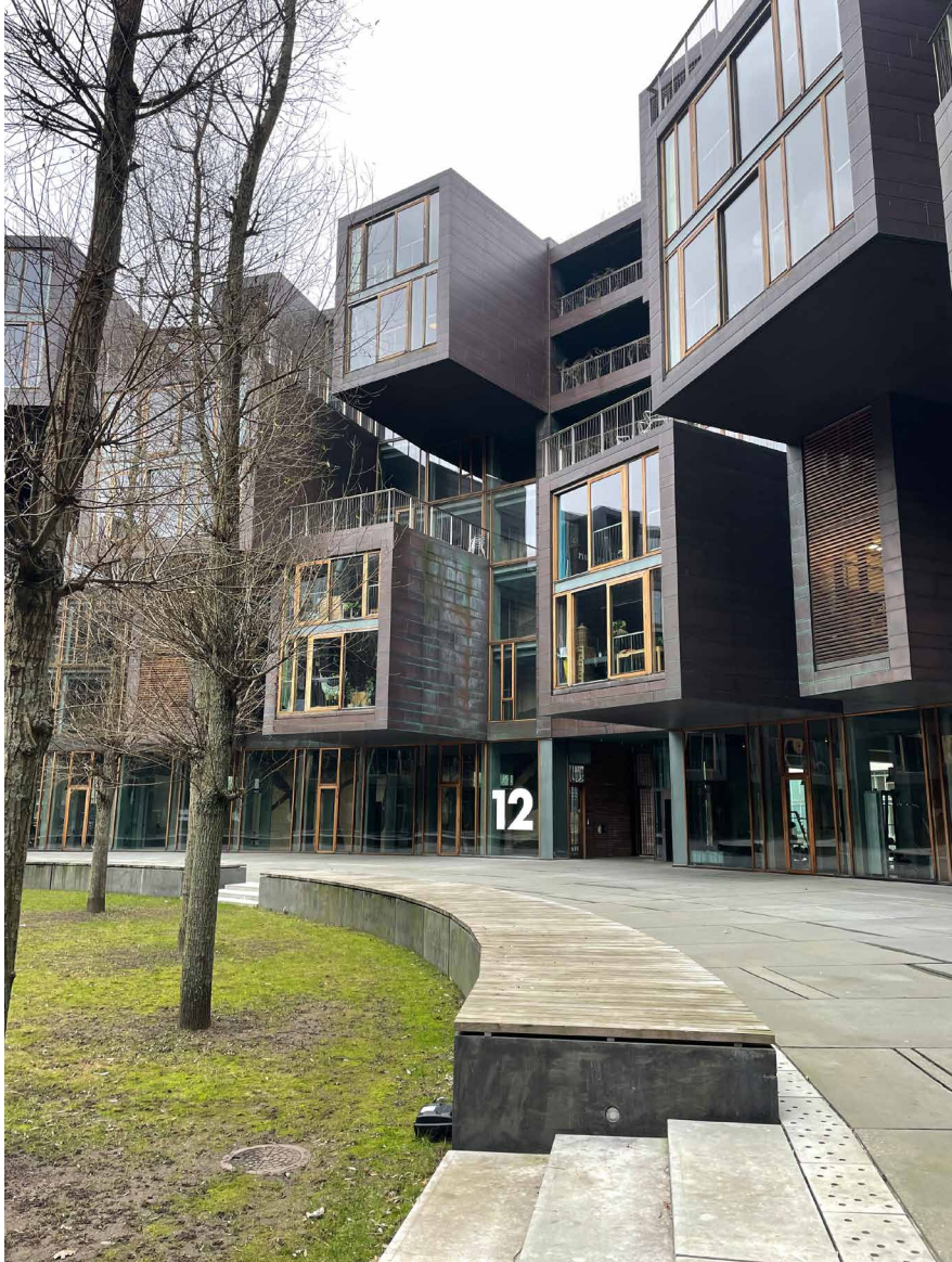
Fig. 12 - Terrazze degli spazi comuni affacciano su spazi verdi favorendo l'interazione tra studenti, ospiti e residenti. Residenza Tietgen a Copenhagen (Lundgaard & Tranberg Arkitekter).
