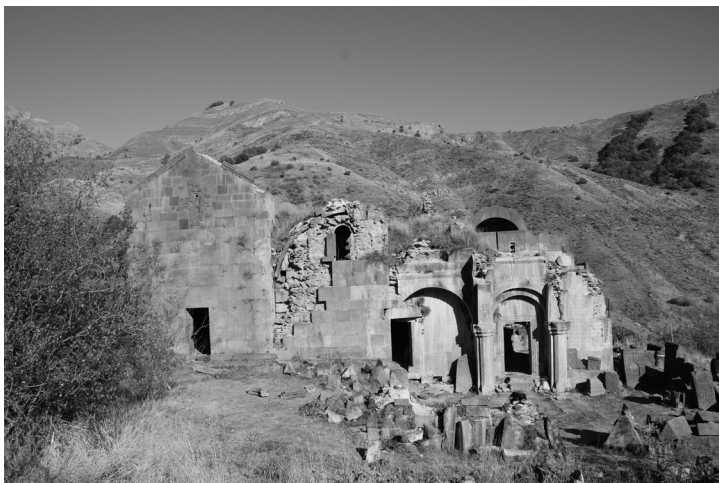
Fig.2 Monastero di Arates. Stato di fatto, vista generale del prospetto est. Dove si possono notare le differenti tecniche costruttive delle varie fasi di ampliamento della struttura fra i secoli IV e XIII. Foto dall'autore.
