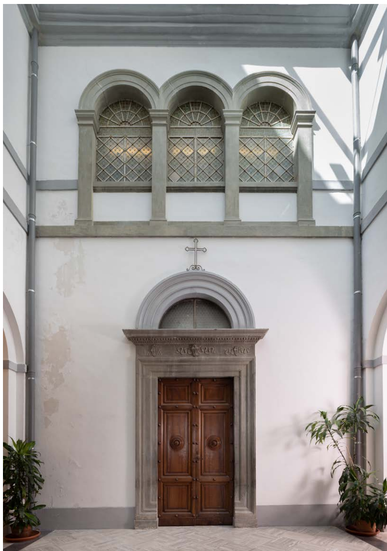
Figura 1.1 • Il portale d'ingresso della cappella del Palazzo San Niccolò. Foto di B. Bruchi.
