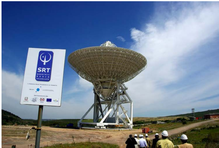
Figura 13 – In Sardegna, a circa 35 km da Cagliari, in località Pranu Sanguni, nel comune di San Basilio, è in fase di completamento un grandioso impianto scientifico, denominato SRT ( Sardinia Radio Telescope ). Si tratta di un radiotelescopio del diametro di 64 m, di concezione moderna, disegnato per applicazioni di Radioastronomia, Geodinamica e Scienze Spaziali, che si configura come una facility internazionale di altissimo profilo. Il gruppo di ricerca RF, Microonde ed Elettromagnetismo si è occupato dello studio di diverse problematiche relative al progetto elettromagnetico dell'antenna, tra cui vale la pena ricordare il progetto del front-end a 22 GHz per il fuoco gregoriano del radiotelescopio (i polarizzatori sono stati realizzati dalle società Pasquali Microwave Systems di Firenze, mentre le antenne a tromba dalla CLOEMA di Bagno a Ripoli).
