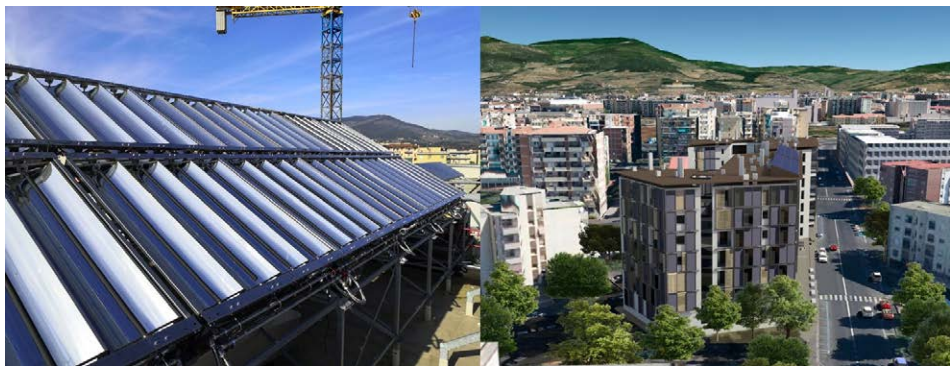
Figura 131 – PED – Impianto Pilota di FIRENZE Torre degli AGLI.
