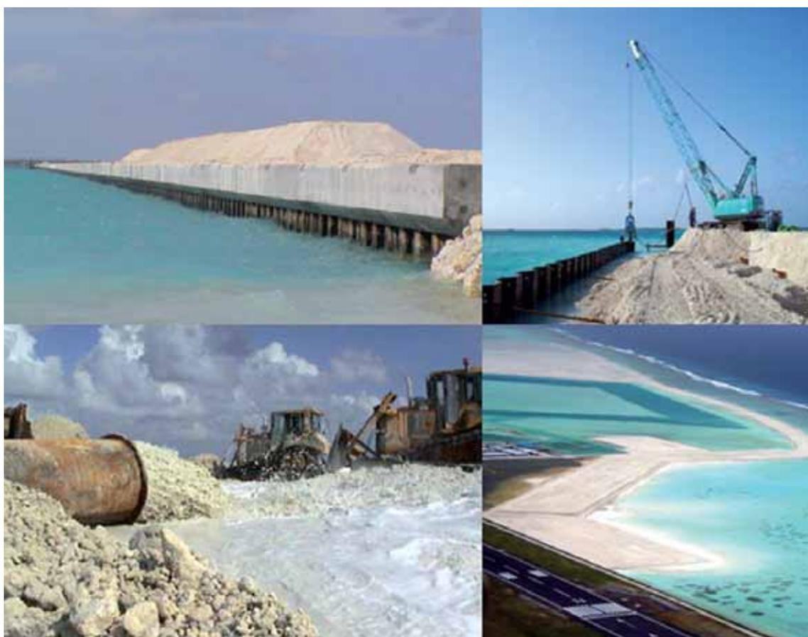
Figura 1.20. Hulhumale avrà una estensione in superficie pari a quella attuale dell'isola di Malé, circa 195 ha. Il riempimento di sabbia corallifera ha una quota finita di 2 mt sul livello del mare, un metro più alta dell'isola di Malé. Per la proiezione delle banchine è in fase di realizzazione un canale di guardia proprio sulla barriera corallina, oltre la quale il fondale si inabissa bruscamente, come accade in tutte le isole oceaniche.
