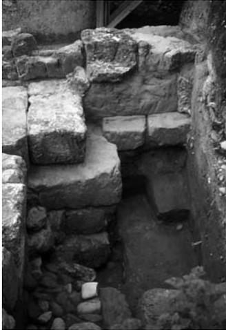
Fig. 26.13 La risega alla terza assisa di fondazione della torre e alla prima assisa di fondazione delle mura costiere.
