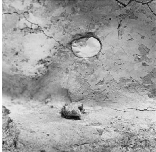
Fig. 13.10 Particolare del perno che fissava originariamente la lastra di base all'interno di un coppo.
