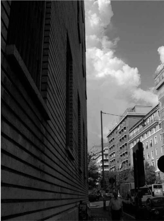
Figura 1.3. Palazzo Postale in Piazza Bologna, Roma. Dettagli del paramento esterno in listelli di travertino dell'isola del Giglio.
