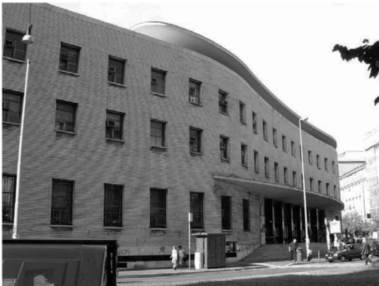
Figure 1.5 (sopra), 1.6 (a fronte). Palazzo Postale in Piazza Bologna, Roma. Viste attuali dell'edificio.
