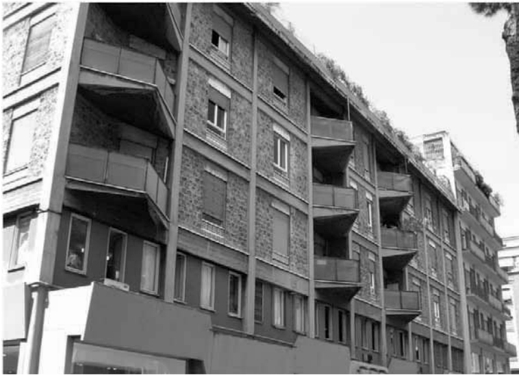
Figura 1.13. Vista generale di casa Chitarrini con il 'fascione' in cemento armato e i terrazzini a sbalzo in primo piano.
