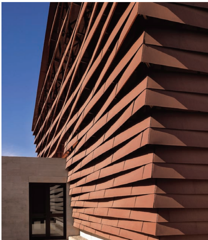
Palestra - Gymnasium, Sesto Fiorentino Architetto Fabio Capanni, Firenze Idroflorence S.r.l., Badia a Settimo Scandicci (FI) TECU® Classic
