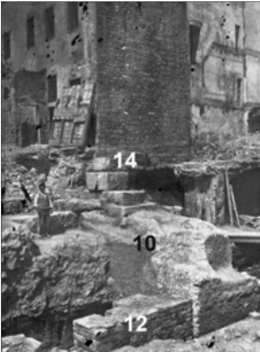
Figura 37. Fotografia delle demolizioni con i numeri di riferimento della veduta a disegno (figura 13). In questa foto la chiesa di S.Maria in Campidoglio era già stata demolita riportando alla luce il lato orientale della case affacciate su piazza della Luna. le demolizioni procedettero dall'area del Mercato Vecchio (più bassa) verso Sud, riportando alla luce le fondazioni del tempio
