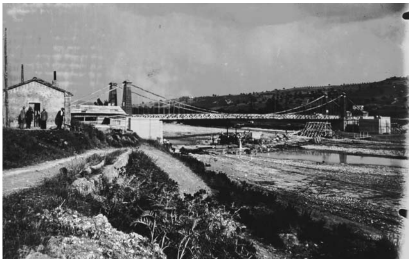
Figura 5 – Ingegneri Turpin e Bigot, Ponte sospeso a catene di ferro sulla Cecina fra Saline e Pomarance in una foto dei primi anni venti del Novecento, durante i lavori di allestimento del cantiere per la costruzione del nuovo ponte in cemento armato progettato dalla Società Anonima per Costruzioni Cementizie Poggi e Muggia, ASF, Fondo Enrico Bianchini, serie III, n. 34.
