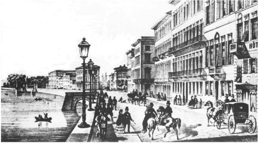
Figura 2 – Candelabri di ghisa del Pignone sui lungarni di Firenze.
