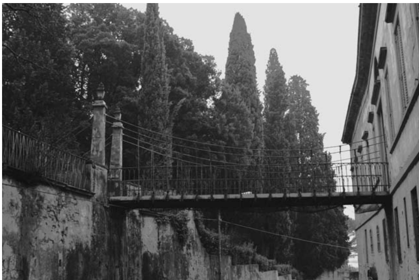
Figura 2 – Ponte pedonale realizzato nel 1825 su progetto dall'ingegner Antonio Carcopino su via di Castello fra il piano nobile di villa Paolina e il giardino (foto dell'autore).
