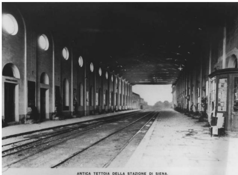
Figura 7 – Tettoia della stazione di Siena.
