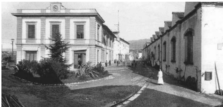
Figura 6 – Le Officine viste dall’ingresso di via Carlo Bini, 1917.
