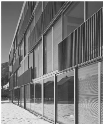
*A sinistra:* Test-room VERU, Istituto di Fisica del Fraunhofer Institut, Holzkirchen, Germania. Monitoraggio delle prestazioni in uso di due facciate realizzate con vetri dalle prestazioni termiche differenti.
