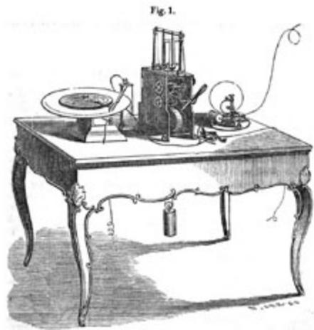
**Figura 10.** Telegrafo di Alexander Bain, che scriveva il Codice Morse su carta elettrochimica, precedente il suo modello di fax (T.P. Shaffner, *The Telegraph Manual: a Complete History and Description of the Semaphoric, Electric and Magnetic Telegraphs of Europe, Asia, Africa and America, Ancient and Modern*, New York, 1859).
