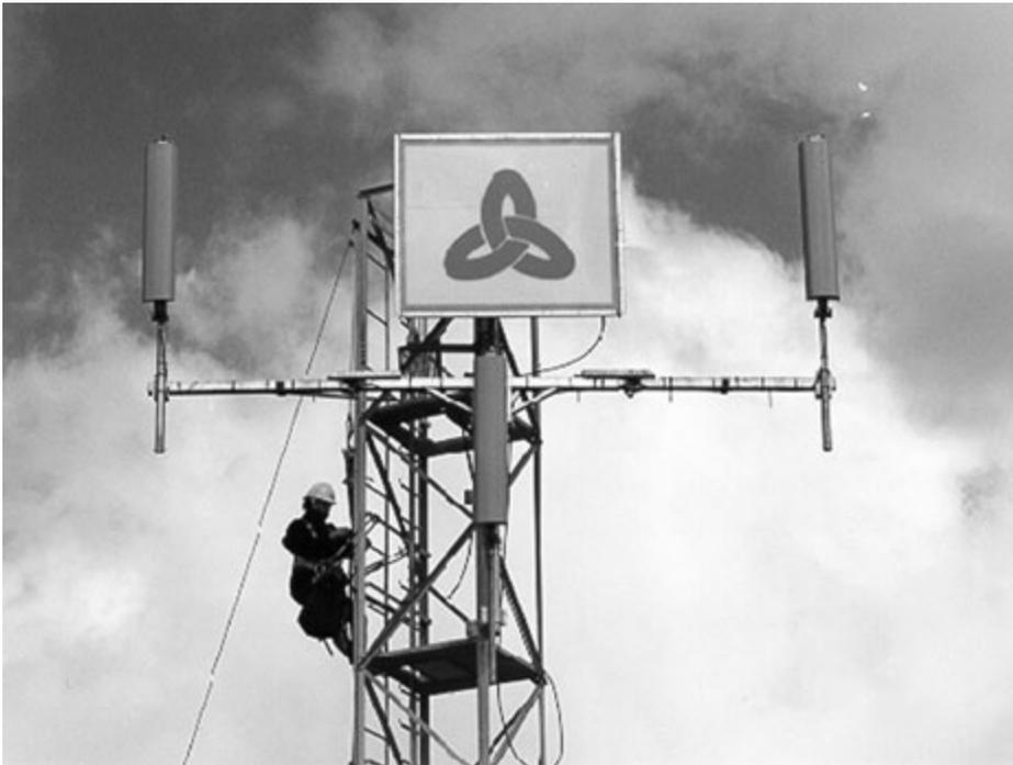
**Figura 4.** "Antenna intelligente ad "array" (antenna "a schiera") per GSM installata su una cella sperimentale a Milano.
