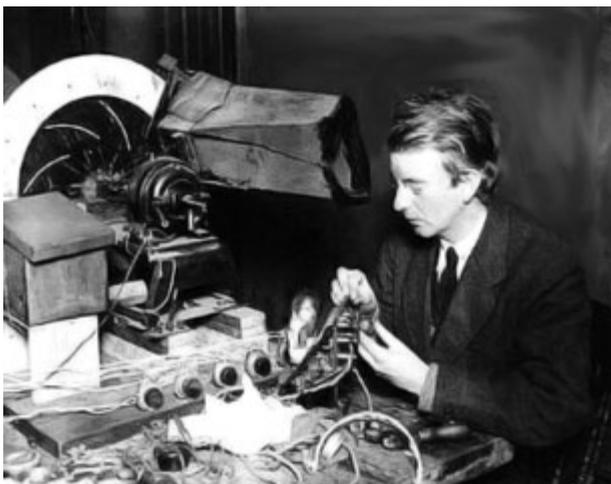
**Figura 16.** J. Baird col suo ricevitore meccanico con disco di Nipkow.
