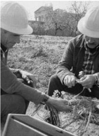
**Figura 12.** Giunzione di un cavo con isolamento in PVC.
