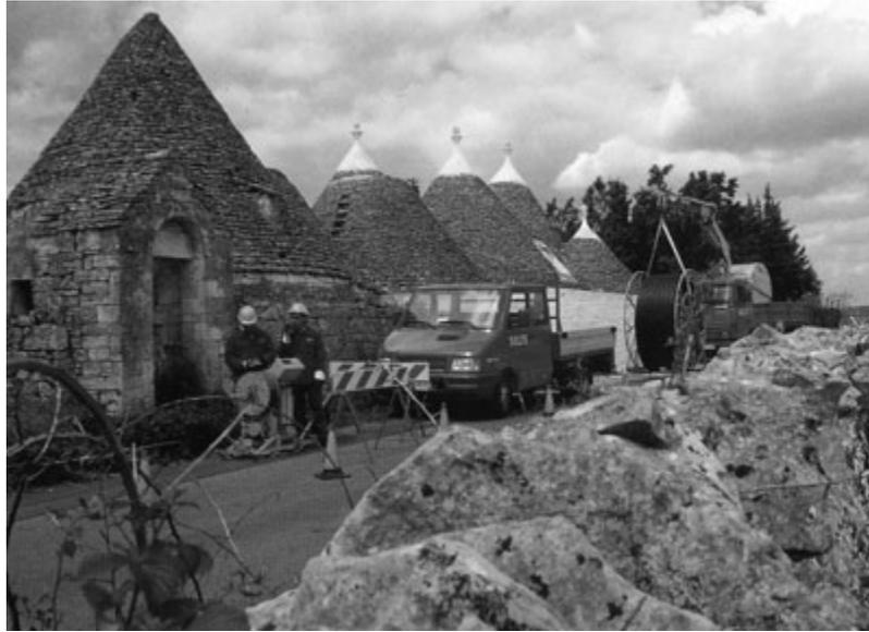
Figura 10. Installazione di cavo ottico in rete distrettuale.
