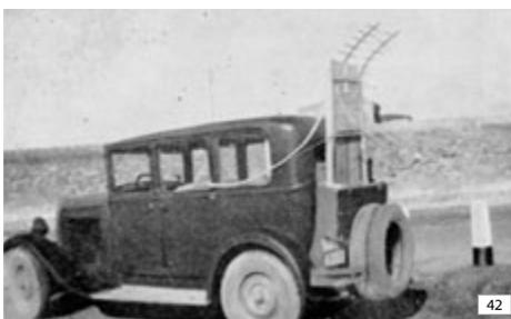
**Figura 42.** Marconi utilizzò anche ricetrasmittitori a bordo di mezzi mobili (qui l'auto dell'Ammiraglio Bottini) per studiare il fenomeno e incrementare la portata.
