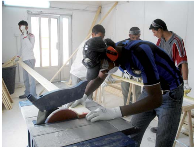
Figura 36. Lavorazione in officina
