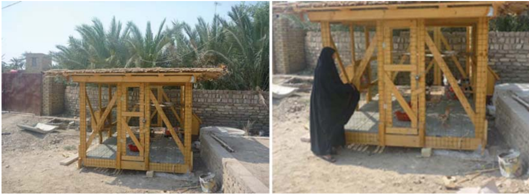
Figura 40. Il ricovero in opera in Iraq (queste immagini si riferiscono alla fase precedente la collocazione sulla copertura dello strato di materiale vegetale previsto dal progetto)
