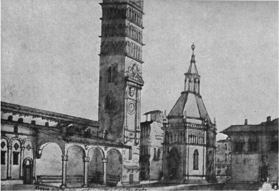
Figura 2. Loggia “della montata” o “del giuramento” in Pistoia che servì per primo teatro pubblico nei secoli XV e XVI. Il disegno è dell’architetto Giuliano Gatteschi di Pistoia. In Alberto Chiappelli, Storia del teatro in Pistoia , cit., tav. I.
