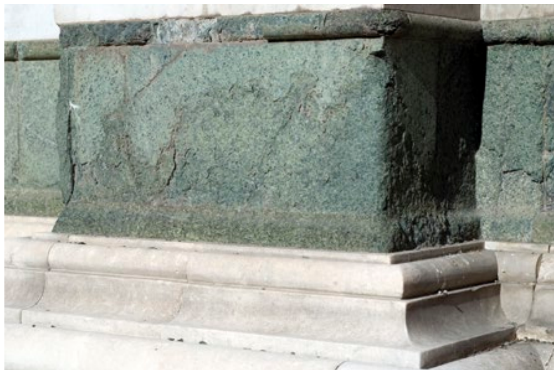
Fig. 16 Particolare del rivestimento in serpentinite della Cattedrale di Santa Maria del Fiore fortemente decoeso per fenomeni di termoclastismo.
