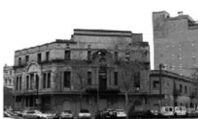
RICONVERSIONE DEL MANUFATTO STORICO IN LOFT
