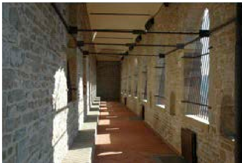
6. Firenze, Palazzo Vecchio, Camminamento coperto a lavori finiti 6. Florence, Palazzo Vecchio, Covered parapet walk on completion of the work
