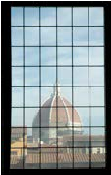
7. Firenze, Palazzo Vecchio, Particolare degli infissi prima dell'intervento 7. Florence, Palazzo Vecchio, Detail of the fixtures before restoration
