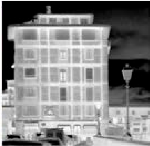
11. Firenze, edilizia moderna anni '50, il termogramma permette di riconoscere l'intelaiatura della struttura portante dell'edificio
