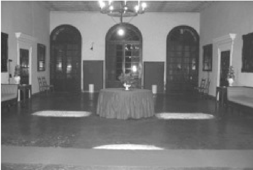
5. Costozza (Vicenza), Villa Trento-Carli, salone principale con le grate di aerazione 5. Costozza (Vicenza), Villa Trento-Carli, main salon with air vents
