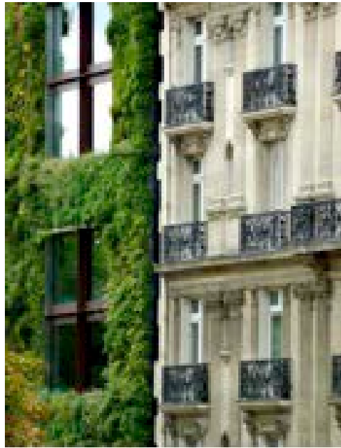
4. Parigi, Musée de quai Branly. Particolare della facciata vegetalizzata (arch. J. Nouvel; facciata vegetale di P. Blanc, 2004)
