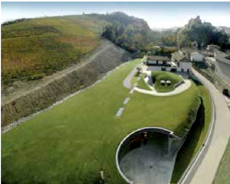
9. Barolo (Cuneo), Castiglion Falletto. Cantina Adelaide (Studio Archicura)
