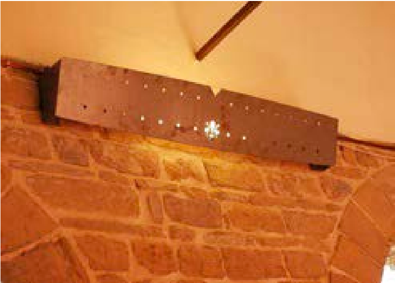
11. Firenze, Palazzo Vecchio, Particolare dei corpi illuminanti nel camminamento coperto 11. Florence, Palazzo Vecchio, Detail of the lighting fixtures in the covered parapet walk
