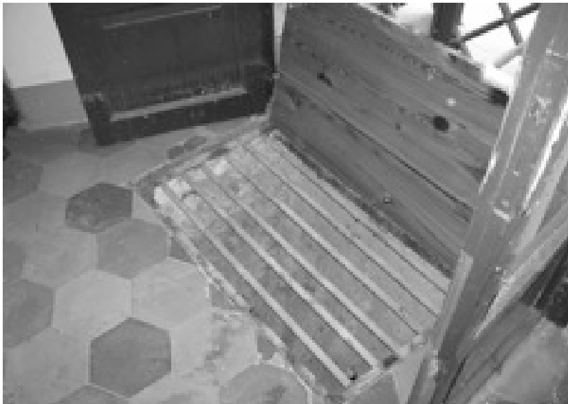
10. Palermo, Palazzo Marchese, salone detto delle colonne, grata per l'aerazione
