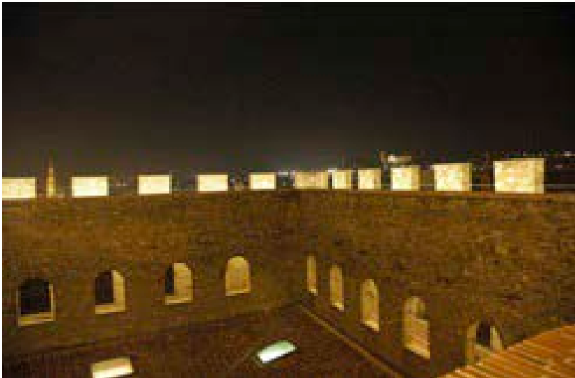
12. Firenze, Palazzo Vecchio, Particolare dei corpi illuminanti nel camminamento scoperto 12. Florence, Palazzo Vecchio, Detail of the lighting fixtures in the open parapet walk
