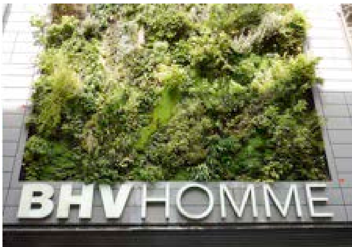
5. Parigi, Boutique BHV Homme (Arch. F. Michigan; facciata vegetale di P. Blanc, 2006)
