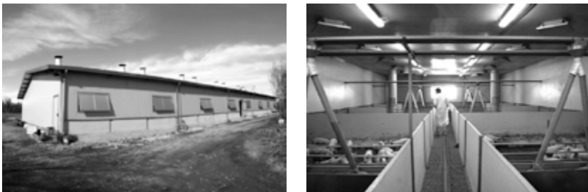
Fig. 1. L'edificio di post-svezzamento (a sinistra) e l'interno di una delle 5 sale di allevamento.
