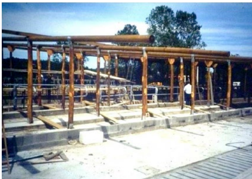
Fig. 7. Stalla in legno autocostruita con materiale aziendale
