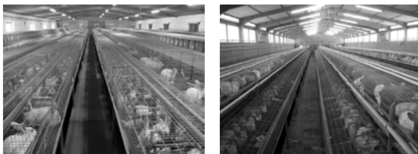
Fig. 1. I due allevamenti sede di monitoraggio sperimentale: a sinistra edificio con ventilazione forzata trasversale (allevamento A), a destra longitudinale (allevamento B).
