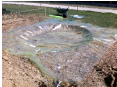
2 - Impermeabilizzazione della vasca
