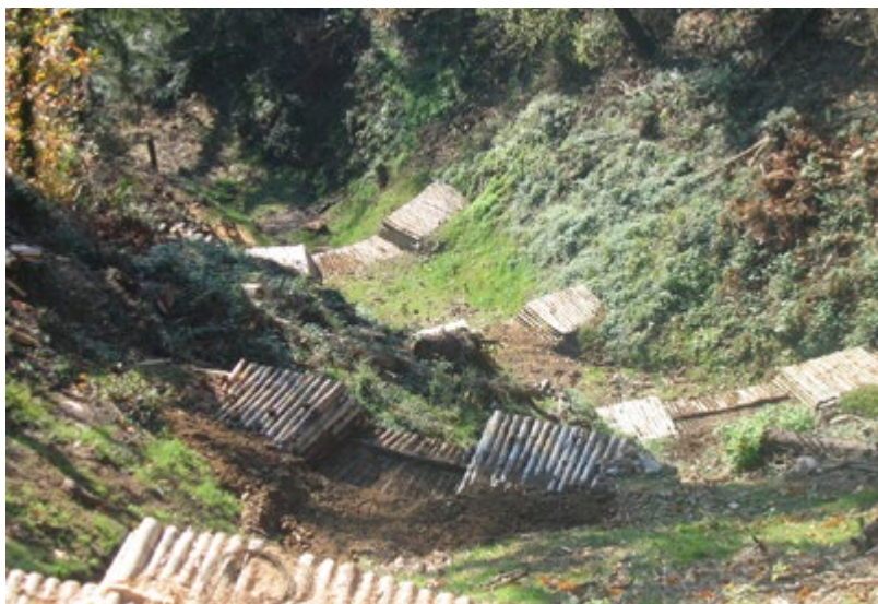
Figura 3. Intervento di ingegneria naturalistica per la stabilità dei versanti: briglie in palificata di legno.
