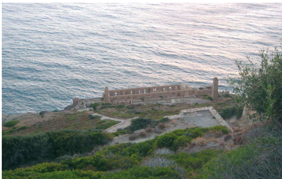
Fig. 10.10 Laveria Lamarmora a Nebida, esempio di integrazione tra strutture industriali e paesaggio.
