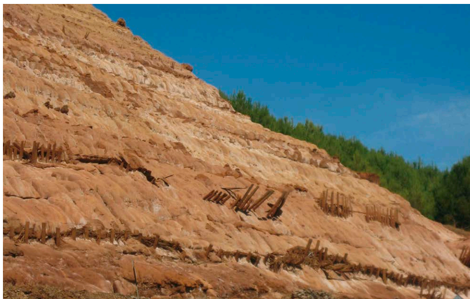
Fig. 5.1 Discarica dei fanghi rossi di Monteponi, si tratta di residui dell'impianto elettrolitico dello zinco, oggi soggetti a dilavamento a causa dello scolo delle acque. Per limitare l'inquinamento sono stati ricoperti da una sostanza sintetica trasparente
