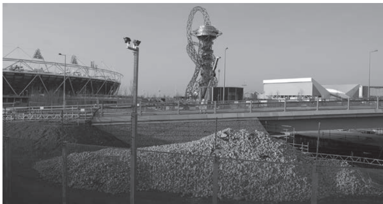
Cantiere dell'Olympic Park di London 2012: Stadio con travatura reticolare realizzata riusando tubature per il gas (risparmio 2.500 ton.di acciaio); cls frantumato derivante dalla demolizione di edifici preesistenti sul sito, riciclato come riempimento di gabbioni per le spalle dei ponti; Aquatics Centre con due ali temporanee (capienza 17.500 posti) da rimuovere dopo i Giochi per lasciare solo il corpo centrale (2.500 posti) per future manifestazioni sportive. / Construction site of London 2012 Olympic Park: the Stadium shows trusses built by reusing gas pipes (saving 2,500 tons of steel); crushed concrete arising from the demolition of existing buildings on the site, recycled in bridges abutments; the Aquatics Centre with two temporary wings (capacity 17,500 seats) designed to be removed after the Games, leaving only the central body (2,500 seats) for future sports events (Source: original photograph by the author, Stratford, London (UK), March 2012).
