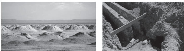
Fom Zguid, Marocco. Esempio di riproposizione del sistema qanat persiano con i pozzi di aerazione caratteristici, ampliamento del qanat esistente. Operazioni di scavo e consolidamento dei canali grazie a pietre e calcestruzzo messi in opera a umido. / Fom Zguid, Morocco. Example of a Persian qanat system with the characteristic ventilation shafts. Enlargement of existing qanat. Excavation and consolidation of channels with stones and concrete (Source: flickr).
