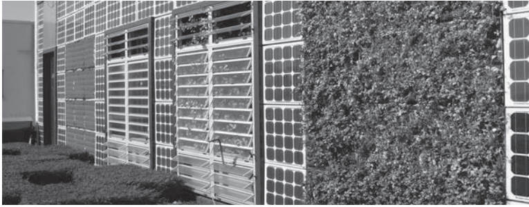
Edificio sperimentale per il monitoraggio di facciate vegetali finanziato dalla ditta Intemper. / Experimental building for monitoring vegetal facades funded by the company Intemper.
