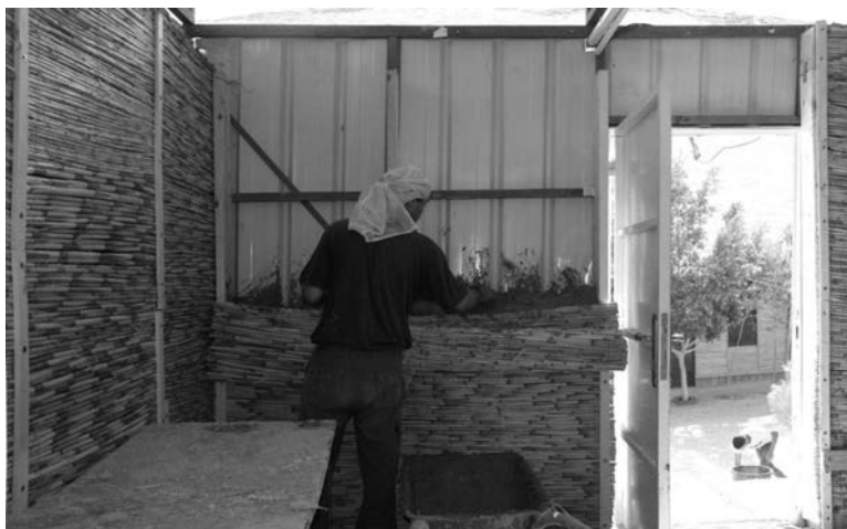
Costruzione della scuola a Wadi Abu Hindi, Territorio Occupato Palestinese, 2010. Tecnica Pisè. / Construction of the School in Wadi Abu Hindi, Occupied Palestinian Territory, 2010. Pisè Technique.
