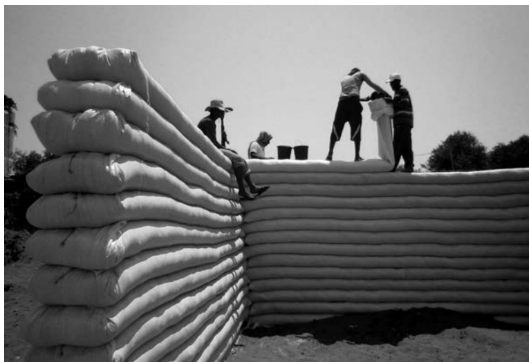
Costruzione della scuola a Um al Nasser, Striscia di Gaza, 2011. Tecnica Earthbags. / Construction of the School in Um al Nasser, Gaza Strip, 2011. Earthbags Technique.
