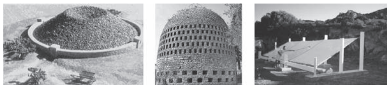
Evoluzione dei sistemi per la condensazione vapore acqueo contenuto nell'aria: modello del condensatore di Zibold (1912) a Theodosia, Ucraina; Condensatore di Knapen (1932) a Trans-en-Provence, Francia; installazione di teli per la raccolta delle nebbie (2000) a Vignola, Italia. / Development of systems for condensing water vapor contained in the air: model of the Zibold's room of condensation (1912) in Theodosia, Ukraine; Knapen's room of condensation (1932) in Trans-en-Provence, France; installation of panels for the collection of fog (2000) in Vignola, Italy (Source: PUR International Organization for Dew Utilization, www.opur.fr ).
