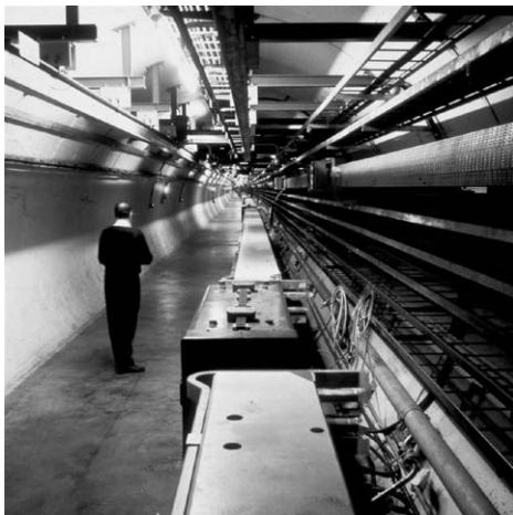
Figura 26. Una vista del collisionatore elettroni-antielettroni, LEP (Large Electron Proton Collider) installato nel tunnel dove si trova attualmente LHC.
