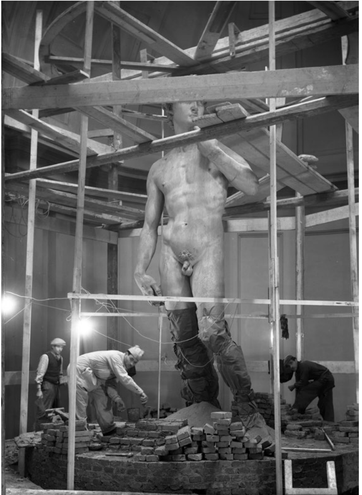
47. Costruzione di una struttura di protezione per il David di Michelangelo, 1942-1943 (Gabinetto fotografico Polo museale fiorentino).
