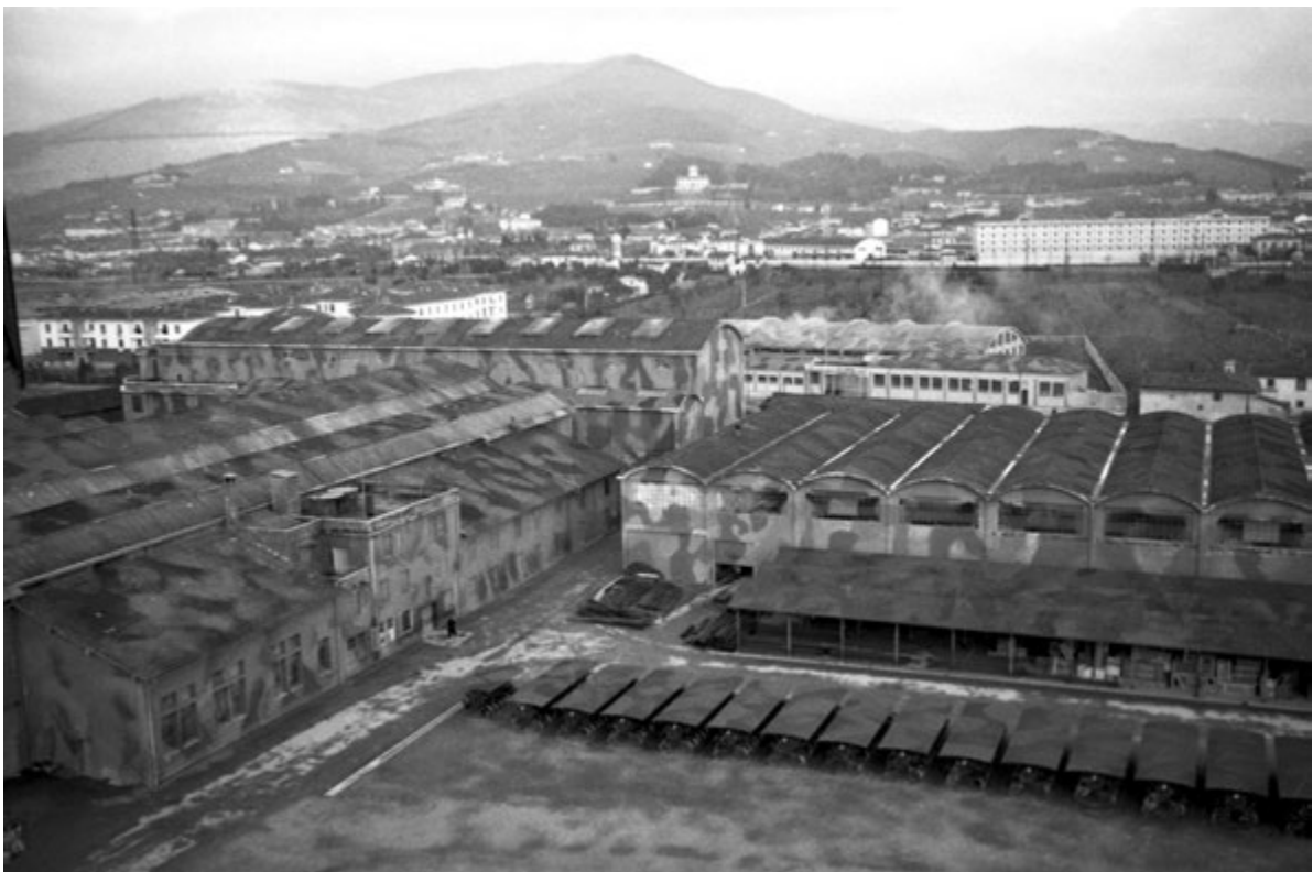
11. Mimetizzazione degli impianti produttivi del Pignone, 1939 (© Copyright Archivio Foto Locchi).
