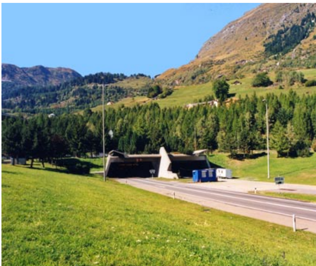
Figura 1. Autostrada N2. Il portale della galleria autostradale del San Gottardo.
