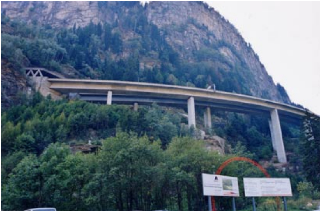
Figura 10. Il viadotto di Monte. Sotto i lavori per la nuova linea ferroviaria ad alta velocità Alptransit .
