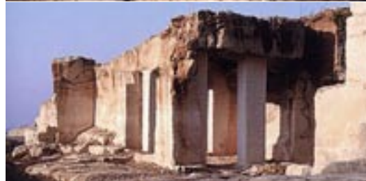
Figura 9. Immagine del luogo prima dei lavori autostradali (senza data).
