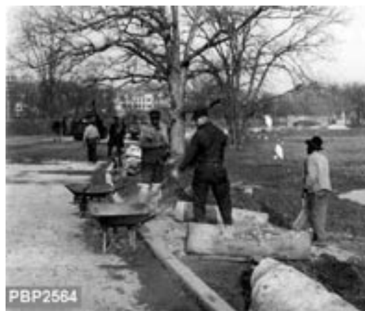
Figura 12. Lavori lungo la Bronx River Pk. (dicembre 1923).
