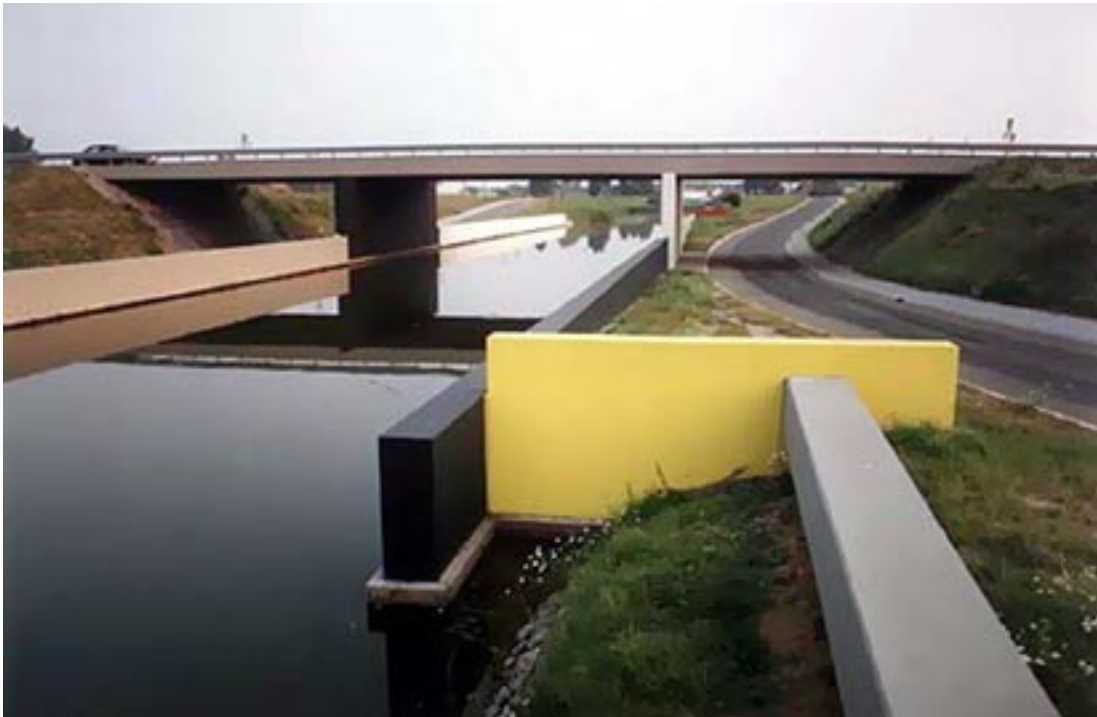
Figure 120-121. Autostrada S47 Olanda.
