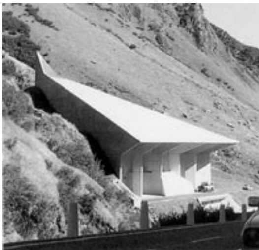
Figura 5. Pozzo di ventilazione al Motto di Dentro sul San Gottardo.
