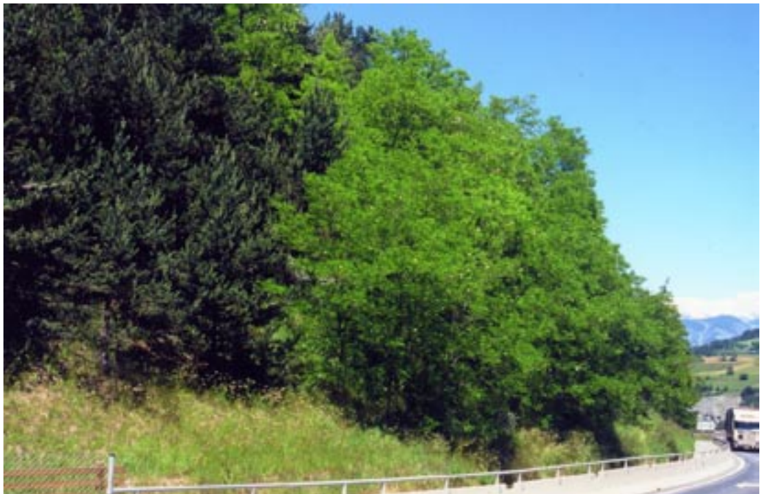
Figura 16. Schiechtl. Opere di ingegneria naturalistica lungo l'autostrada del Brennero: la grata viva dopo trentaquattro anni dalla realizzazione (2001).
