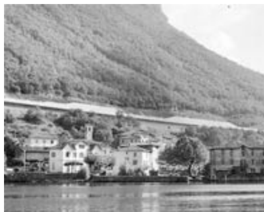
Figura 3. A Capolago il piano stradale viene eseguito su di uno sbalzo che crea una lunga linea di ombra che riduce visivamente l'incombenza del muro di sostegno.
