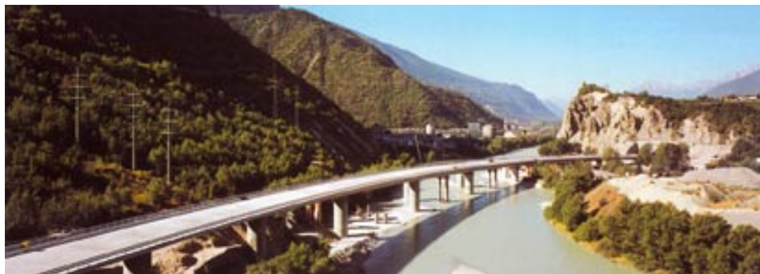
Figura 17. Viaduc de l'Ile Falcon composto da due carreggiate indipendenti presso G ronde.
