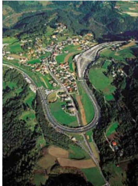
Figura 6. Galleria per la protezione dal rumore presso Schönberg (Austria).
