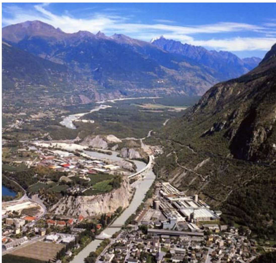
Figura 1. Veduta generale della valle e del tratto autostradale A9 (in costruzione) tra Sierre e Brig. Sulla sinistra in riva al lago l'area di intervento Espace Auguste Piccard (ancora non realizzato), centrale il viadotto di Ile Falcon, sullo sfondo la foresta di Finges che costeggia il fiume Rodano.
