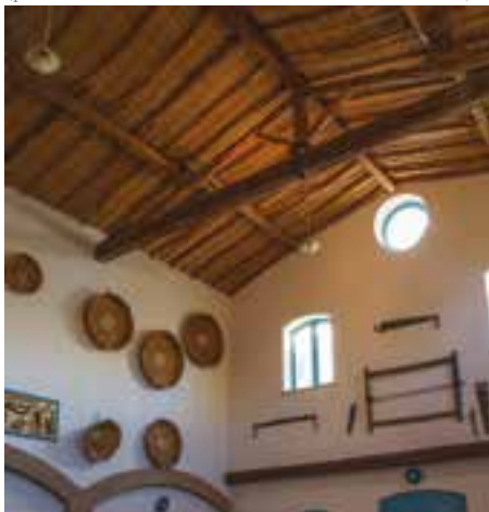
Fig. 6 Traditional truss in Samassi, Sardinia, Italy (photo: Associazione Nazionale Città della Terra Cruda).
