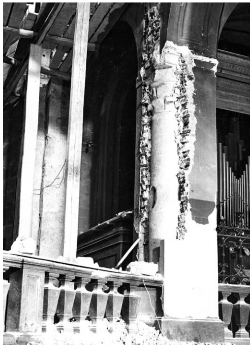
Fig. 36 – Nell'immagine vengono mostrati alcuni pilastri presenti all'interno della Pieve di San Lorenzo a Borgo San Lorenzo (Fi) costruiti inglobando precedenti colonne in riferimento ai danni patiti dalla chiesa dopo il sisma del 1542. Durante i lavori di restauro operati a seguito del terremoto del 1919 furono eliminati i pilastri riportando alla luce le colonne sottostanti.
