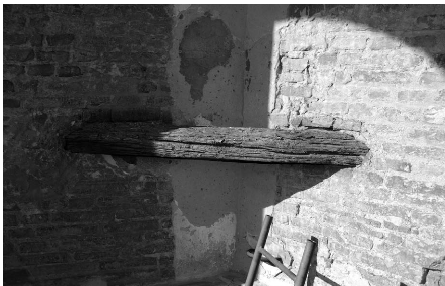
Fig. 31 – Catena in legno inserita in un cantonale interno del campanile della Pieve di San Lorenzo a Borgo San Lorenzo (FI).
