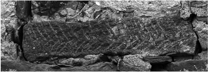
Fig. 29 – Catena in Pietra Serena presente nel prospetto sud della pieve di San Gavino Adimari nei pressi di Barberino di Mugello (FI).
