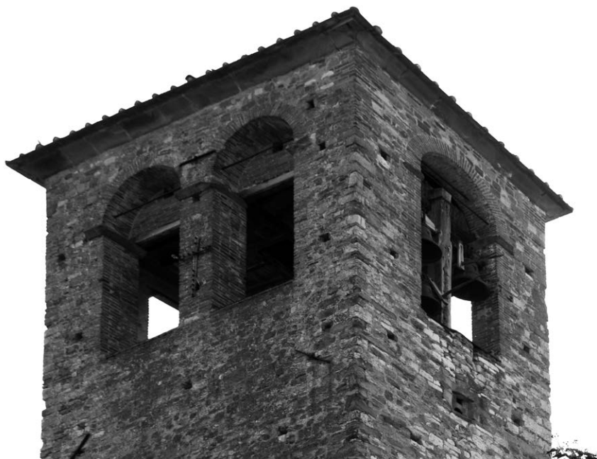
Fig. 14 – Esempi di radiciamenti lignei posti all'altezza dell'imposta degli archi della cella campanaria della Pieve di San Gavino Adimari (FI).
