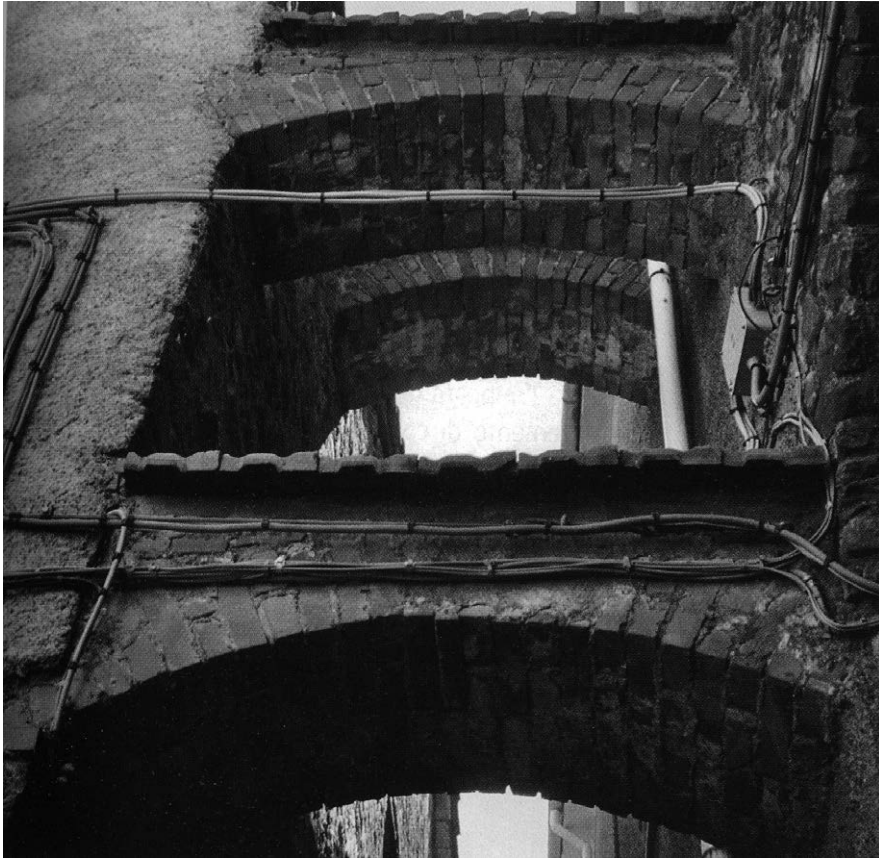
Fig. 30 – Esempi di archi di contrasto. (Fonte: Pierotti 2003: 43-44)
