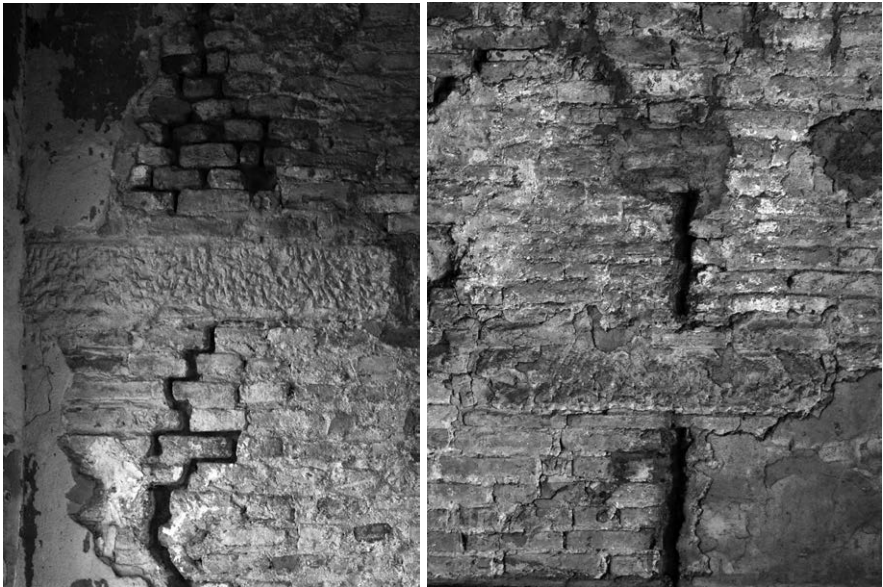
Fig. 30 – Catene in Pietra Alberese inserite in alcune murature interne del campanile della Pieve di San Lorenzo a Borgo San Lorenzo (FI).
