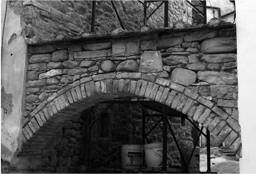
Fig. 12 – Arco di contrasto ubicato all'interno del borgo di Ronta in Mugello (FI).
