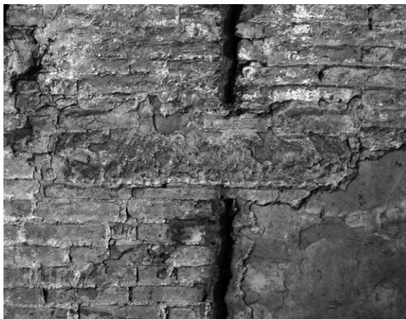
Fig. 10 – Alcuni esempi di catene (in legno, in pietra ed in ferro) inserite nelle murature con funzione di presidi antisismici. Le prime due immagini provengono dalla Pieve di San Lorenzo a Borgo San Lorenzo (FI); la terza fotografia ritrae un particolare della Pieve di San Gavino Adimari (FI).
