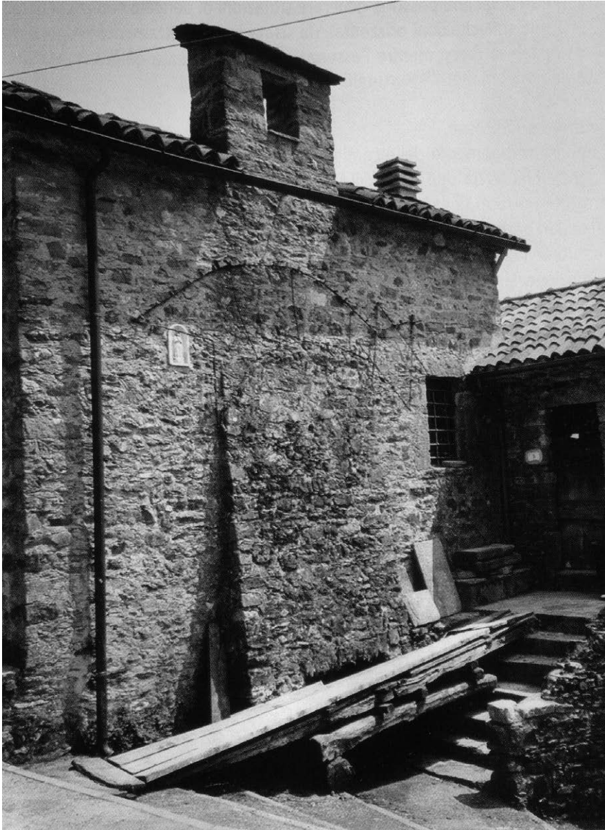
Fig. 28 – Esempio di contrafforte. (Fonte: Pierotti 2003: 56-57)
