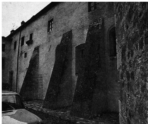
Fig. 35 – Barbacani costruiti nel 1420 nel convento del Bosco ai Frati (FI).
