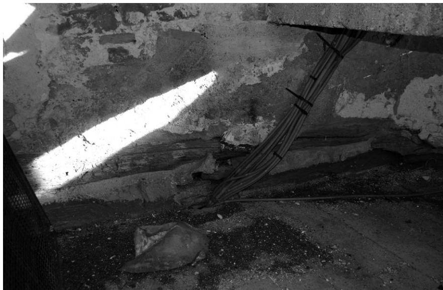
Fig. 33 – Alcune travi di legno che emergono dalla muratura interna del campanile della Pieve di San Lorenzo a Borgo San Lorenzo (FI). Tali elementi cerchiano l'intera struttura architettonica e, dalle relazioni stratigrafiche con le fasi costruttive circostanti, risultano probabilmente messi in opera in riferimento ai restauri operati dopo il terremoto del 1542.
