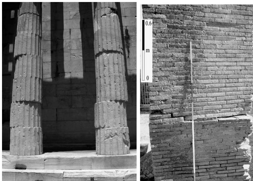
Fig. 1 – Deformazioni e rotazioni dovute a movimenti sismici che interessano alcune colonne dell'Hephaisteion (Theseion) ad Atene (Bottari 2003) e di Ostia a Roma (Galadini et al. 2006).
