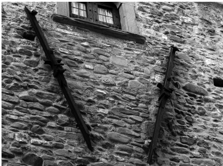
Fig. 32 – Catene in ferro inserite nella muratura esterna del Palazzo dei Vicari di Scarperia (FI).
