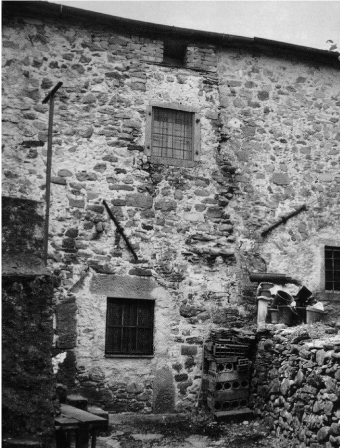
Fig. 27 – Esempi di catene metalliche. (Fonte: Pierotti 2003: 74-76)
