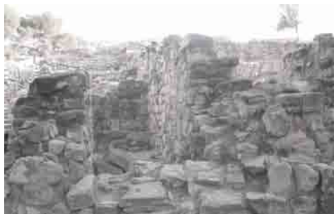
Figura 5. Il corridoio a nord-ovest.
