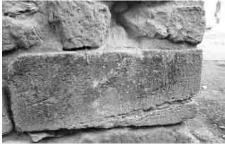
Figura 6. I mason's marks del corridoio.
