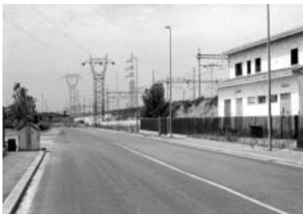
Infrastrutture tecnologiche possono affiancarsi a fasci di infrastrutture viarie, incrementando la congestione degli spazi.
