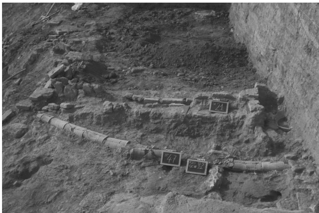
Le installazioni idrauliche delle strutture del III secolo d.C. impostate sui resti spianati del Grande Muro.
