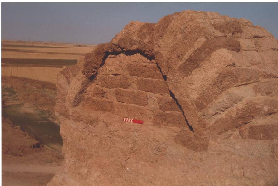
Area A. L'arco in mattoni crudi messo completamente in luce. Purtroppo il degradamento della china ha impedito di comprendere la funzionalità di questa struttura che pare essere una sorta di finestra, poi tamponata.
