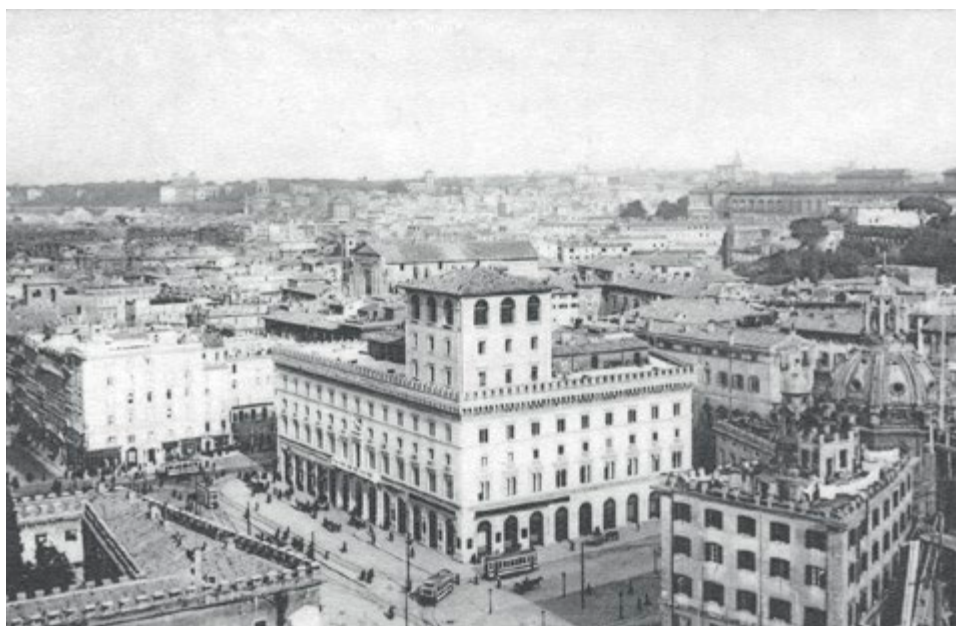
Fig. 24. El Palazzo Generali y el Palazzo Parracciani-Nepoti antes de su demolición.
