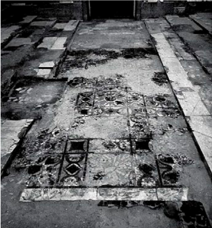
Fig. 91. El corredor interno de la Curia Iulia .
