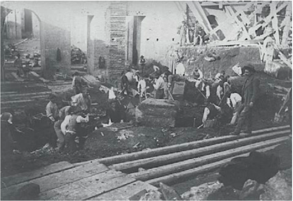
Fig. 19. Excavación en la Via dei Fornari. 22 de enero de 1904.
