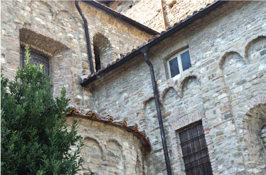
Fig. 14. Bobbio. Chiesa cattedrale di Santa Maria. Transetto absidato e collaterale sud, particolare.
