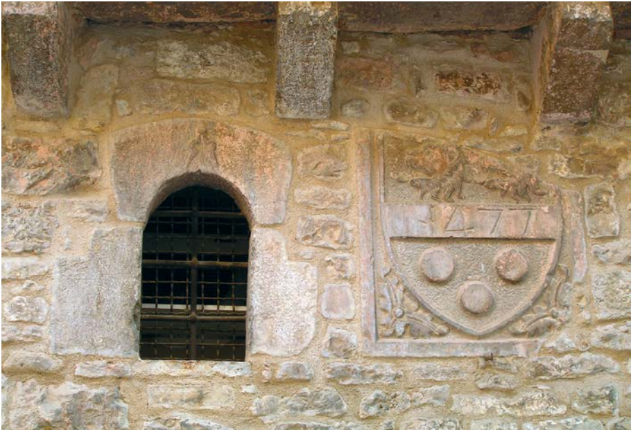
Fig. 17a-b. Assisi, via San Francesco. Loggia dei maestri commacini: generale e dettaglio con la data di costruzione o restauro (foto A. Sereni).
