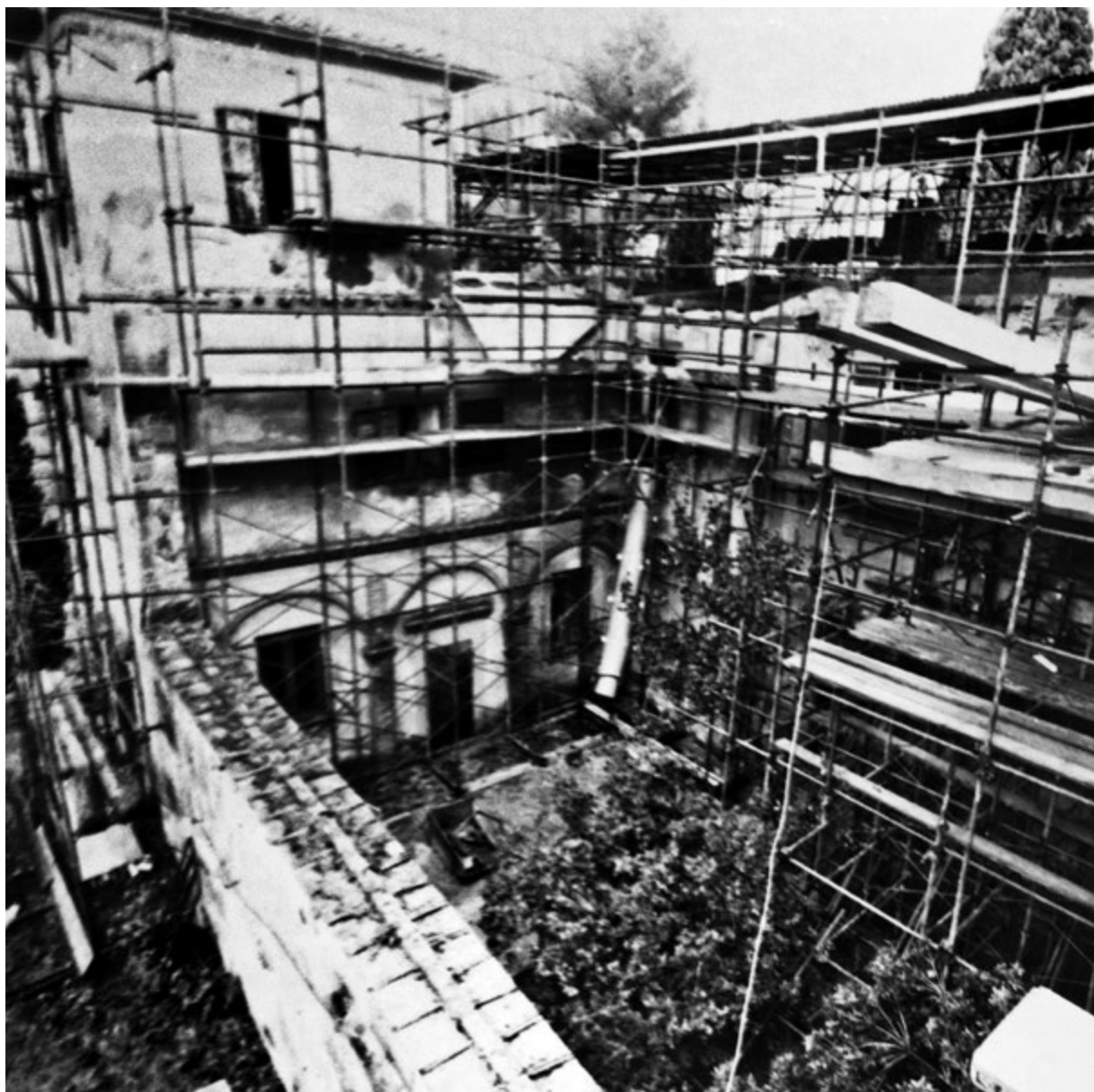
Fig. 29. I lavori di restauro nel 1987. Firenze, Soprintendenza beni architettonici e paesaggio.
