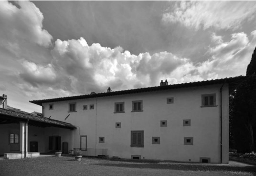
Fig. 11. La facciata laterale nord della villa. A sinistra si scorge il loggiato e la porta di accesso alla «sala».
