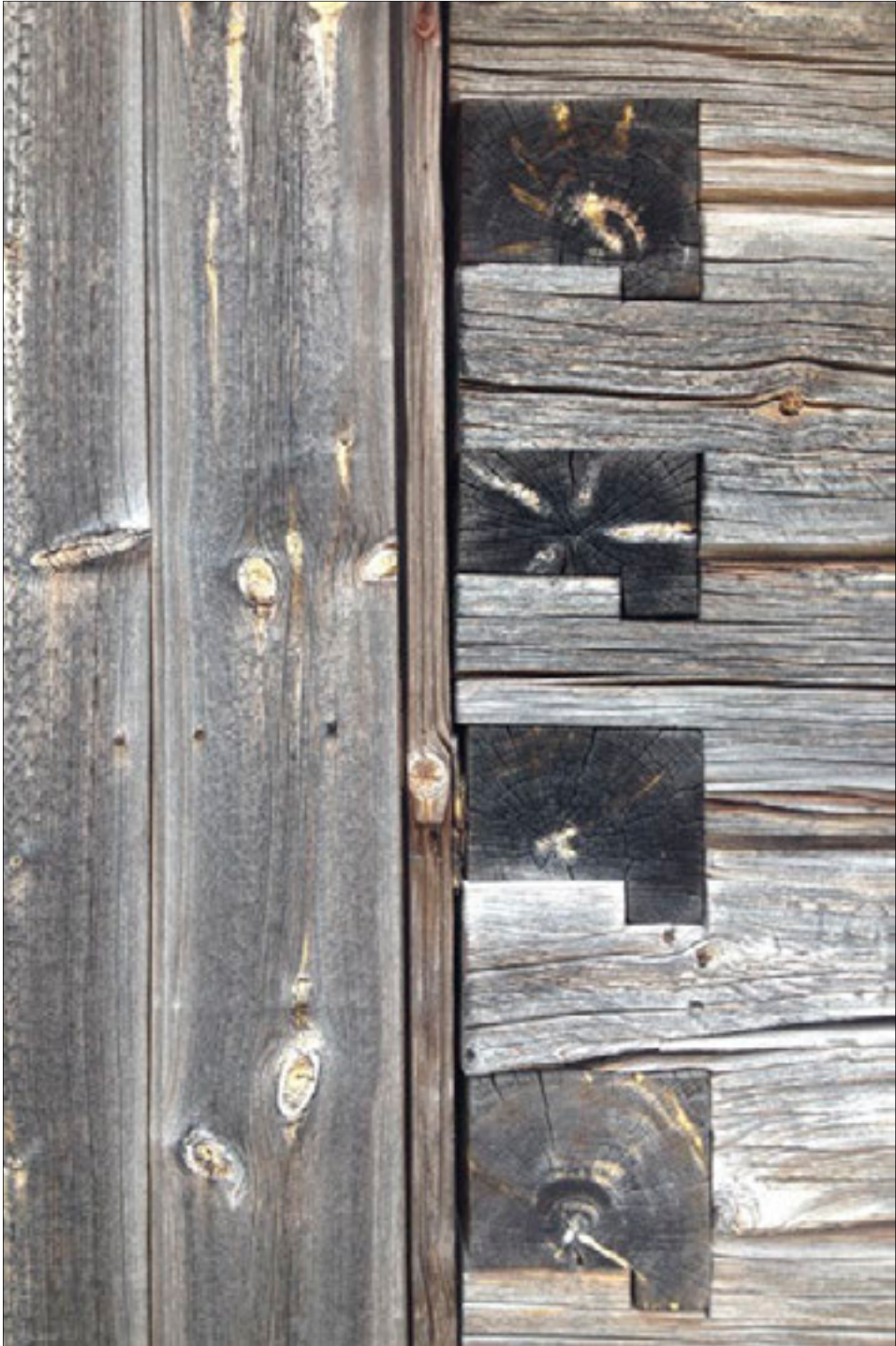
Fig. 35. All'interno della famiglia delle strutture a block-bau si individuano numerose soluzioni differenti per lavorazione dell'incastro e finitura degli elementi lignei. © Sara Porzilli 2016
