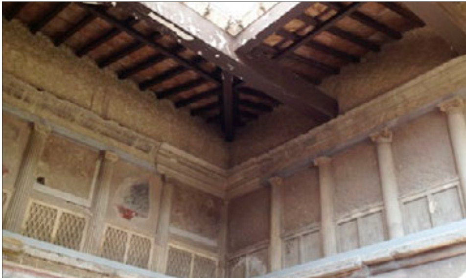
Fig. 13. Nell'architettura romana il legno veniva utilizzato soprattutto per la realizzazione delle strutture portanti di coperture. Un esempio di abitazione da Peastum. © Stefano Bertocci 2012
