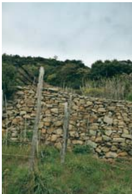
Fig. 34 Un muretto a secco costruito in pietra locale.
